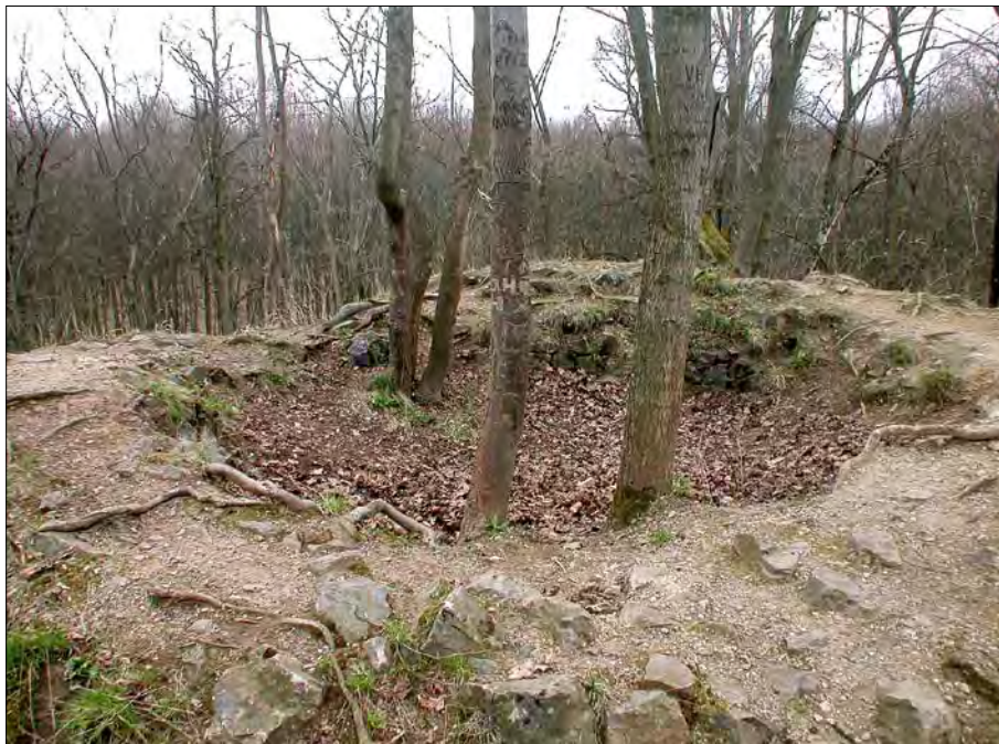
Obr. 47: Lopata, k. ú. Milínov, okres Plzeň-jih. Spodní úroveň zaniklého okrouhlého bergfritu. Dochovaná část objektu v takových případech nepřesahuje úroveň terénu a nezkušenému pozorovateli může připomínat studnu. Foto P. Sokol 2010.
