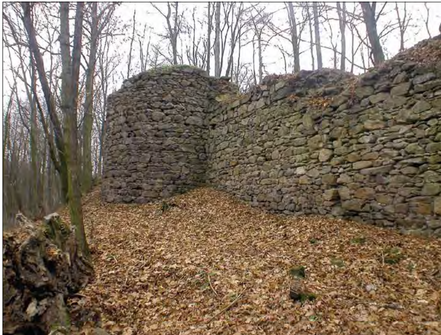
Obr. 52: Prácheň, k. ú. Velké Hydčice, okres Klatovy. Obvodová hradba se systémem střídajících se polookrouhlých a hranolovitých bašt.
