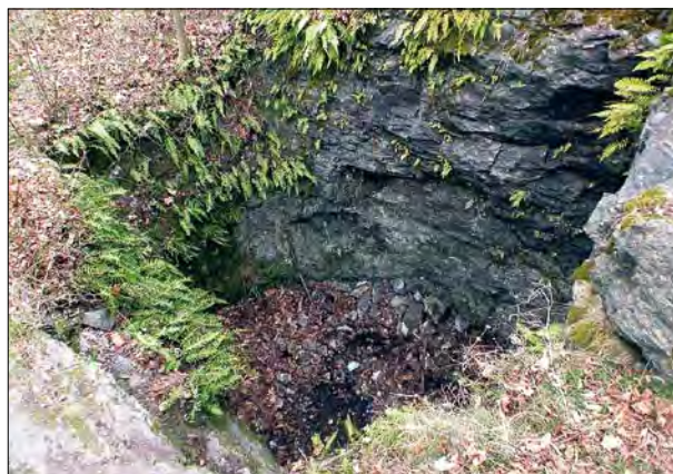
Obr. 62: Lopata, k. ú. Milínov, okres Plzeň-jih. Ve skále vylámaná cisterna na nádvoří hradu. Foto P. Sokol 2010.
