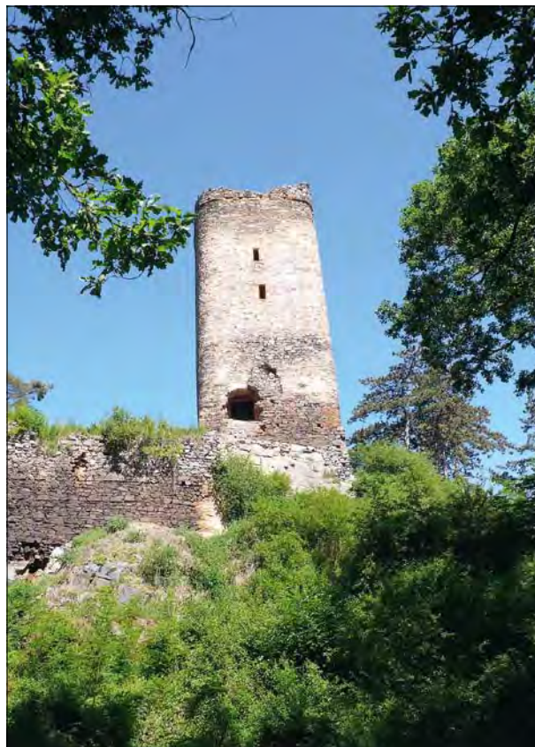
Obr. 43: Libštejn, k. ú. Liblín, okres Rokycany. Bergfrit (hradní obranná věž) na pravoúhlém půdorysu se zaoblenými nárožními. Foto P. Sokol 2011.
