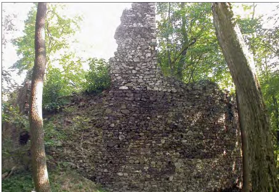
Obr. 75: Nový Herštejn, k. ú. Němčice u Kdyně, okres Domažlice. Vyrovnávací spáry a barevné odlišnosti v důsledku postupu zdění obvodové hradby. Foto P. Sokol 2010.
