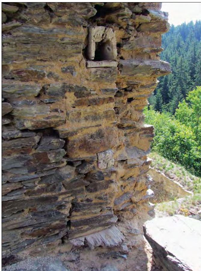
Obr. 77: Gutštejn, k. ú. Okrouhlé Hradiště, okres Tachov. Dochované dřevěné pouzdro na okenní závoru, zbytek dřevěného okenního sedátka a zhlaví trámku mezi nimi. Foto P. Sokol 2012.
