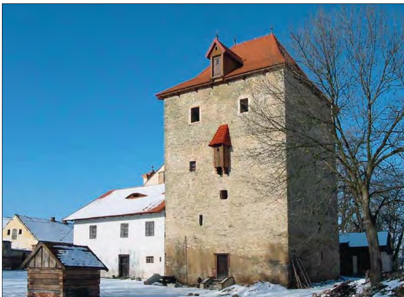
Obr. 23: Lštění, okres Domažlice. Hlavní budova tvrze po rekonstrukci. Foto L. Foster 2010.
