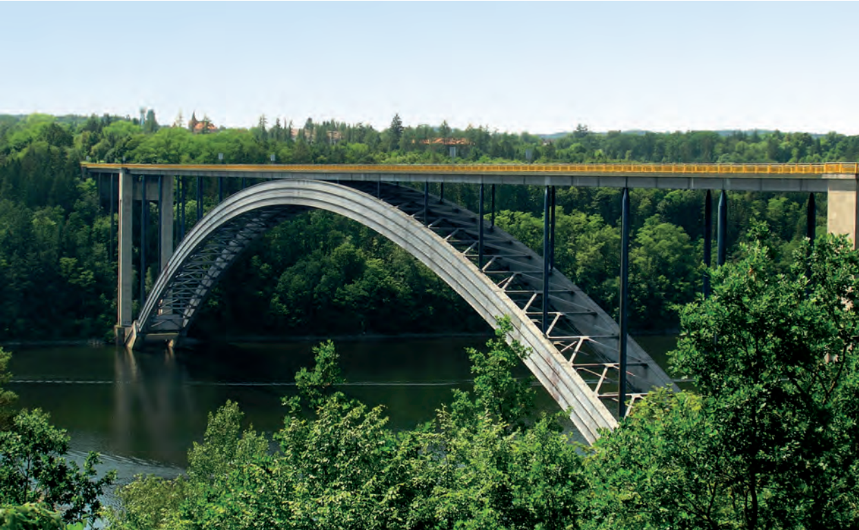
Žďákovský silniční most, foto Pavel Hájek
