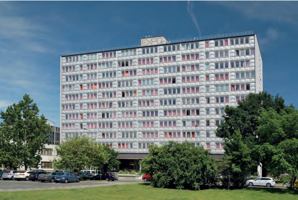
Hotelový dům na sídlišti Invalidovna v Praze
