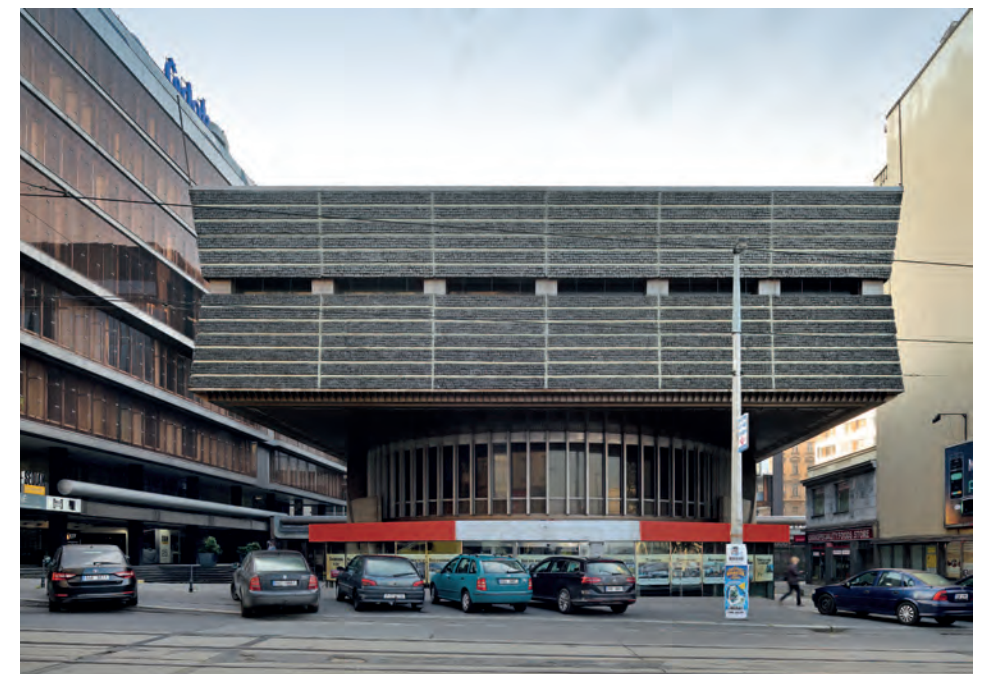
Komplex budov společnosti Transgas v Praze
