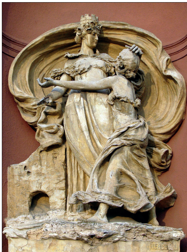
Obr. 29. Praha, pavilon lapidária Národního muzea na Výstavišti, štuková výzdoba z přestavby v roce 1908. Masišní rozpad exponovaných částí štukového reliéfu zhotoveného na bázi moderních hydraulických pojiv (hlinitanový cement). Foto: Petr Kuneš.
