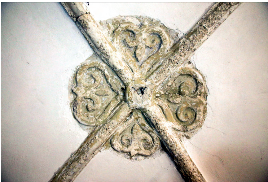
Obr. 42. Při necitlivém odstraňování druhotných vrstev špachtlí došlo k poškození vlastní hmoty štukového svorníku. (Zámek Hranice, detail klenby. Foto: Zdeněk Kovářik)
