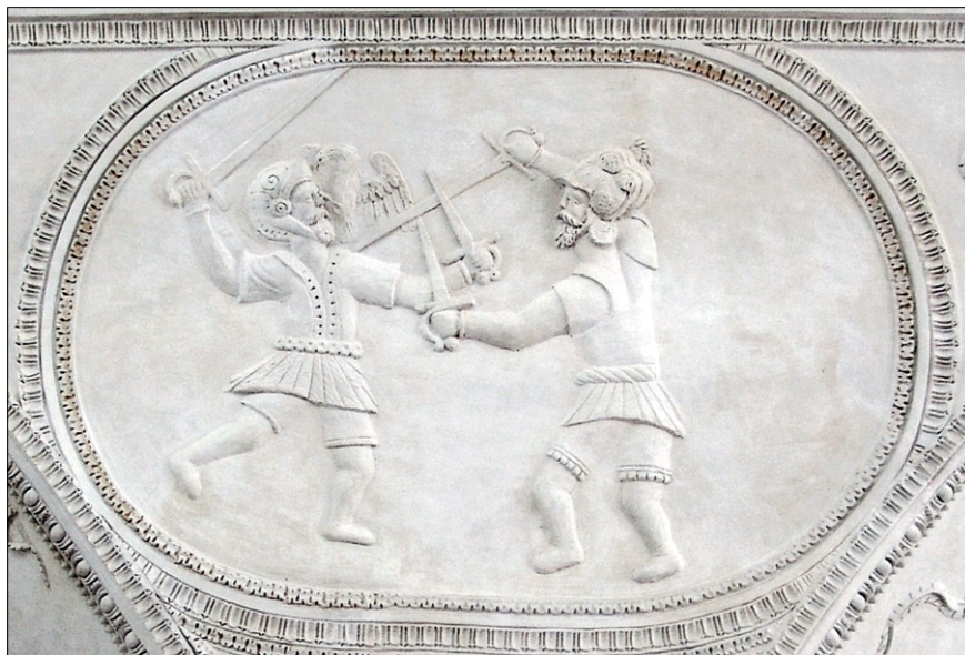
Obr. 40. Tvarově svévolná rekonstrukce štukového reliéfu, která nerespektuje grafickou předlohu, dle níž byla provedena původní renesanční kompozice. Místo napodobení původního složení byl reliéf navíc zhotoven v materiálově nevhodné sádře. (SZ Kratochvíle, Zlatý sál, doplněk pochází z restaurování v 50. letech 20. století, byl odstraněn během restaurátorských prací v letech 2006–2009 a nahrazen štukovým reliéfem vycházejícím z grafické předlohy Josta Ammana. Foto: Jana: Waisserová, 2005).
