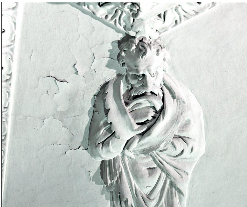
Obr. 37. Nekompatibilní, značně pojený druhotný nátěr se plošně odděluje od štukatury. Vrstva nátěru i v tomto případě zaslepuje původně ostře zpracované partie modelace, které záměrně kontrastovaly s měkkou modelací jiných částí. (Praha, letohrádek Hvězda, 2019. Foto: Petr Kuneš)
