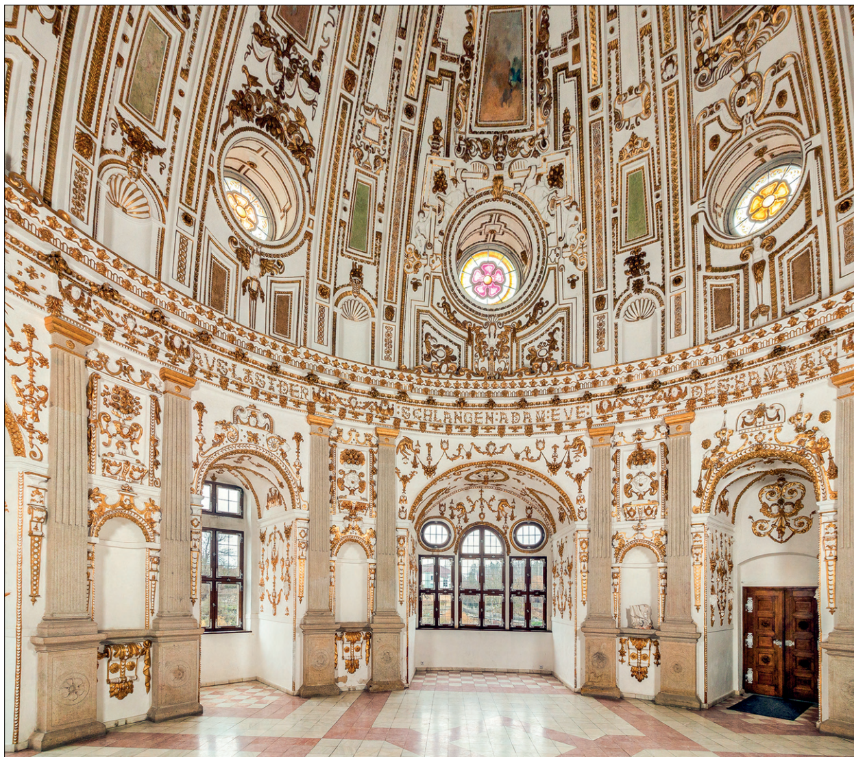
Obr. 44. Posun celkového ztvoárnění interiéru a rozorh zlacených částí štukatur vytvořil dříve neexistující novotvar, neboť nerespektuje poznatky o starších podobách památky, které byly doložené předcházejícím restaurátorským průzkumem. Původní rozsah zlacení byl dle průzkumů podstatně méně dominantní a pouze akcentoval určité detaily výzdoby. (SZ Jindřichův Hradec, Rondel, stav interiéru v roce 2019 odrážející celkovou obnovu ze 70. a 80. let 20. stol., rozsah i provedení zlacení bronzí v olejovém pojivu byly předmětem sporů již v době realizace zásahu. Foto: Vojtěch Krajiček)
