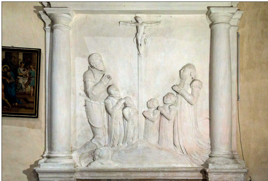
Obr. 36. Opakované nátěry postupně zcela znečitelnily původní modelaci štukového díla. (Český Rudolec, kostel sv. Jana Křtitele, Epitaf rodiny Jana Hodějovského z Hodějova, stav před restaurováním v roce 2019, pod vrstvami mladších nátěrů byl ve velkém rozsahu nalezen polychromovaný povrch renesančního štuky, který byl v tomto případě restaurátorsky obnoven. Foto: Kateřina Šíbravouá)
