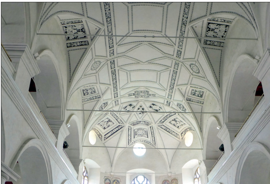
Obr. 43. Celková rekonstrukce štukové renesanční klenební sítě se sgrafitovou ornamentální výzdobou vychází z původního renesančního rozvrhu, ale materiálově ani technologicky původnímu provedení neodpovídá – štuky jsou provedené v cementové maltě a sgrafito znázorněno kontrastní černobílou malbou. (Mladá Boleslav, Sbor jednoty bratrské, klenba lodi kostela byla obnovena na počátku 20. století na základě dochovaných otisků štukových žeber; k destrukci většiny původní renesanční výzdoby došlo po r. 1787, kdy byl kostel přeměněn na vojenské skladiště, stav v roce 2018. Foto: Pavla Mikešová)
