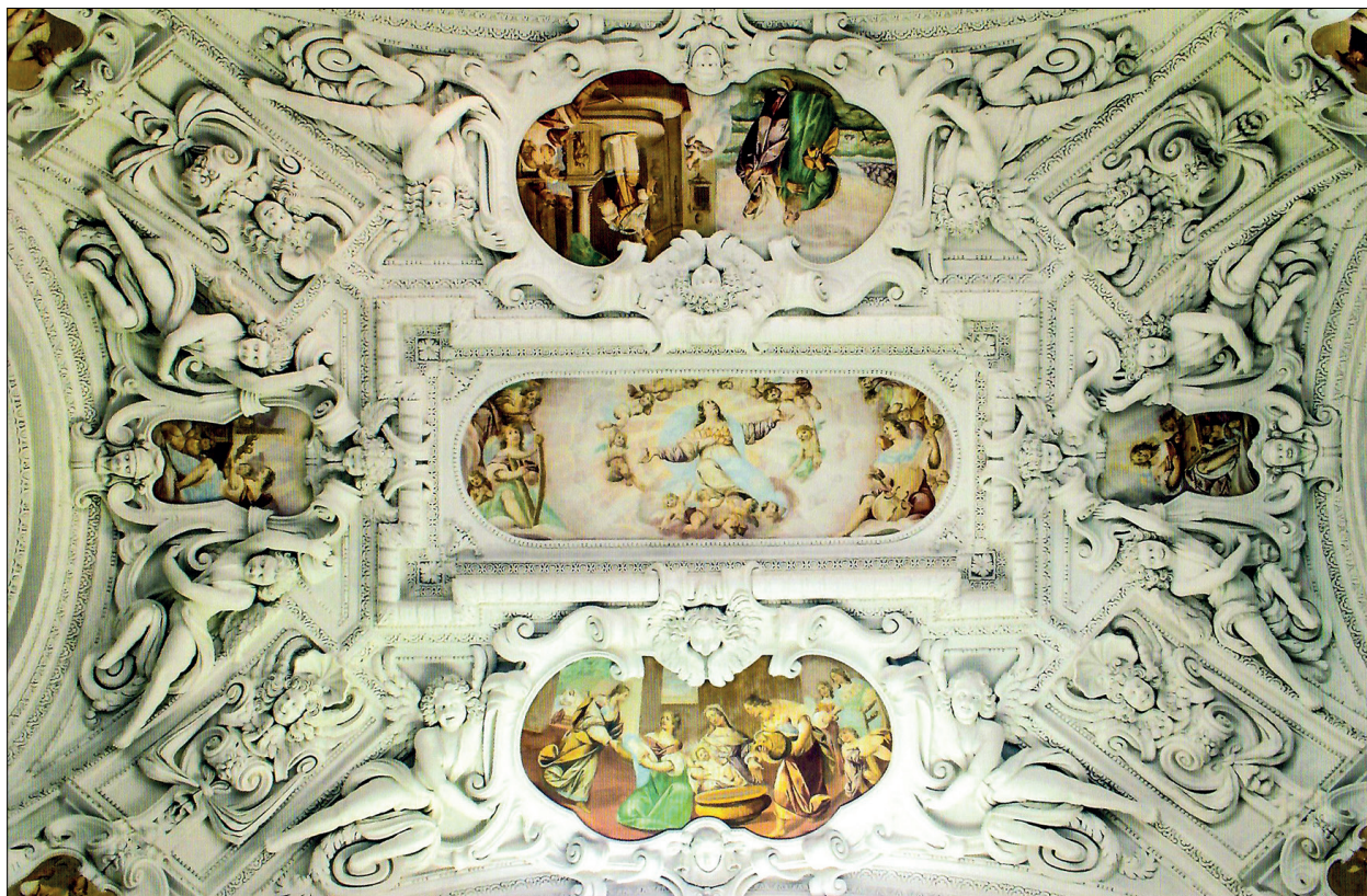
Obr. 12. Náchod, zámek, kaple Nanebevzetí Panny Marie, Carlo Serena (štuková a sochařská výzdoba), 50. léta 17. století. Příklad barokního propojení bohaté a výpravné štukové výzdoby s malířskou výzdobou. Oba výtvarné obory jsou harmonicky komponovány s architekturou. Foto: Martin Mádl.
