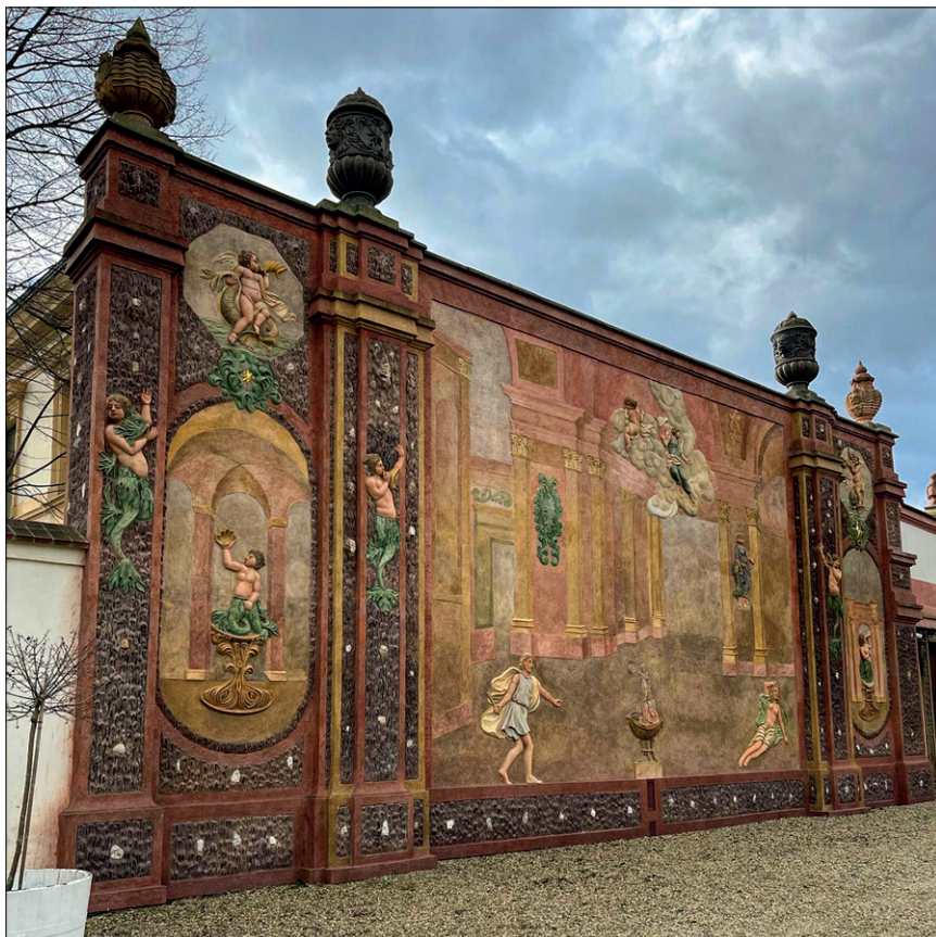
Obr. 47 a 48. Úplná rekonstrukce značně poškozeného štukového díla včetně rekonstrukce jeho polychromie a doprovodné malířské výzdoby může být problematická jak s ohledem na omezenou znalost původní podoby, tak pro nový vzhled, který působí neadekvátně ke stářší díla. (Praha, zámek Troja, prospekt barokního divadla, stav před obnovou v roce 2014 a v roce 2019 po rekonstrukci. Foto: Petr Kuneš)
