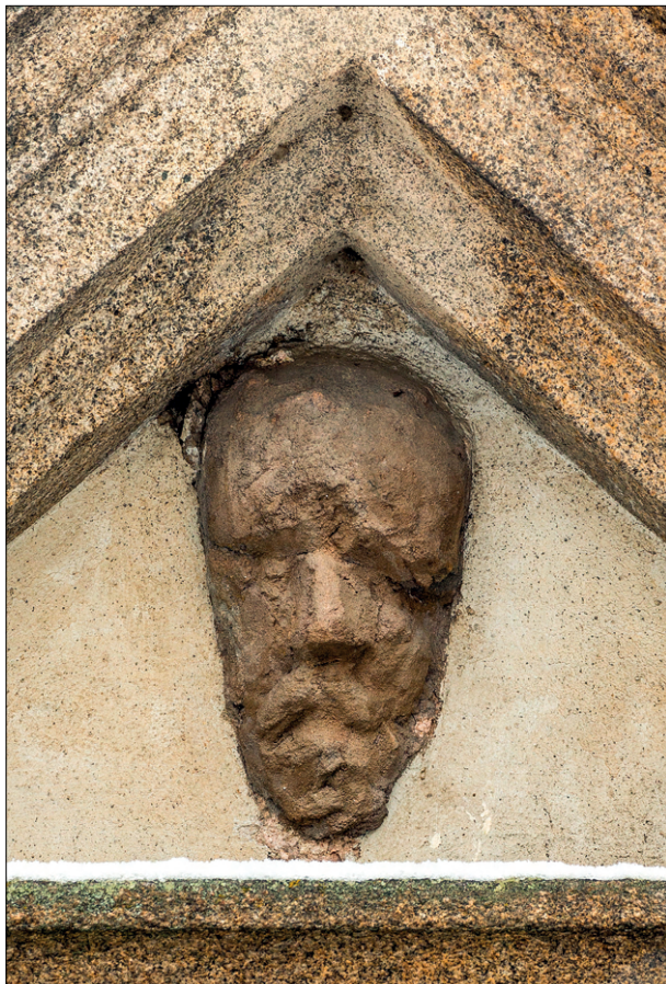
Obr. 32. Původní prvek na bázi vápenného štuku byl v minulosti doplněn a plošně přetažen pevným a málo prodyšným cementovým tmelem, který způsobuje další degradaci originálu. Stav originálu a neznalost jeho původního tvaru pravděpodobně nedovolily přesnější rekonstrukci, výsledkem je tak pouze hrubě naznačená forma původního prvku, který však po zásahu trpí. (SZ Jindřichův Hradec, portál Adamova stavení, stav v roce 2020. Foto: Vojtěch Krajíček)
