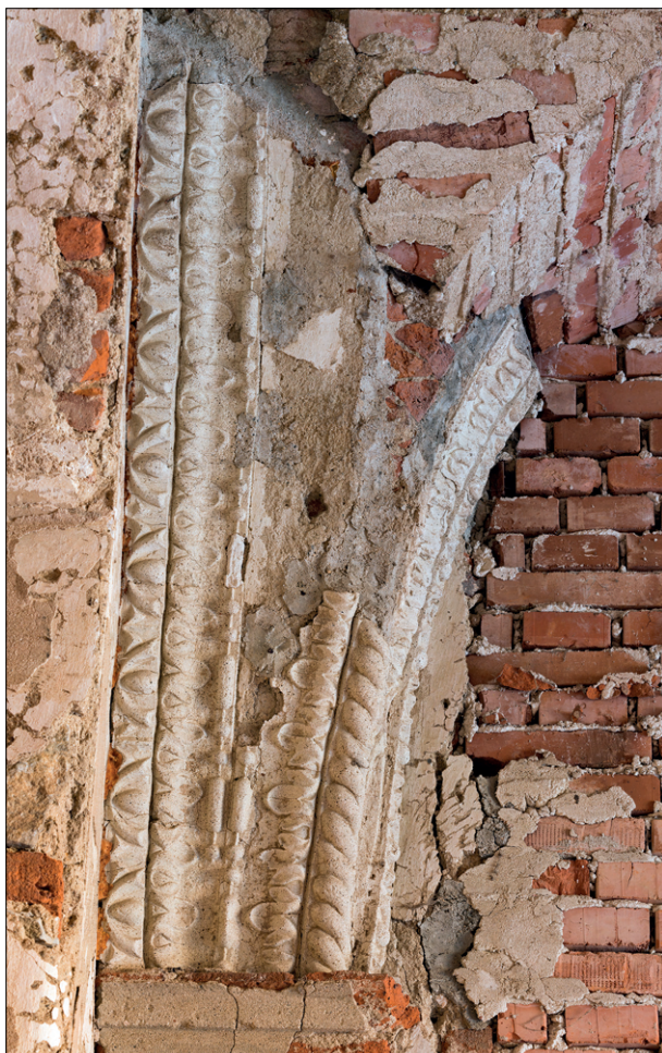
Obr. 28. Uherčice, zámek, západní stěna průjezdu. I malý dochovaný fragment štukové výzdoby dává představu o původním трактовání a členění výzdoby architektury. Rozsah poškození ale může být takový, že celkovou rekonstrukci výzdoby neumožňuje a je třeba hledat jiné cesty jeho prezentace. Uherčice, zámek, západní stěna průjezdu. Foto: Vojtěch Krajíček.
