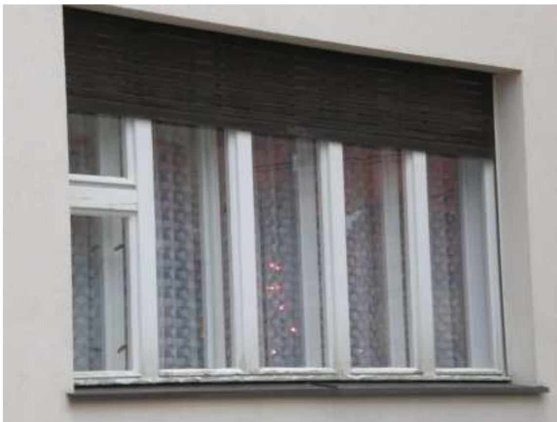
fotografie - detail okna s původní žaluzií: zdroj: Ondřej Wunsch (2008)
