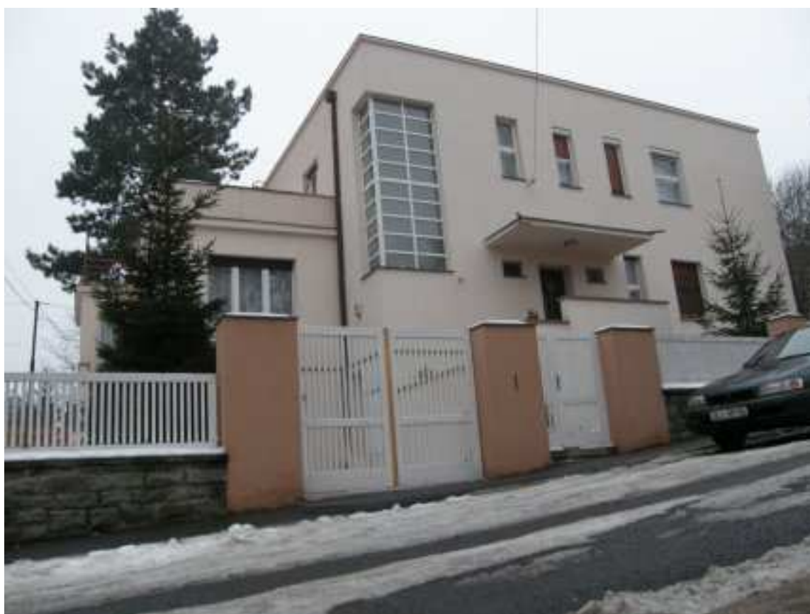
fotografie - fasáda severní: zdroj: Ondřej Wünsch (2008)
