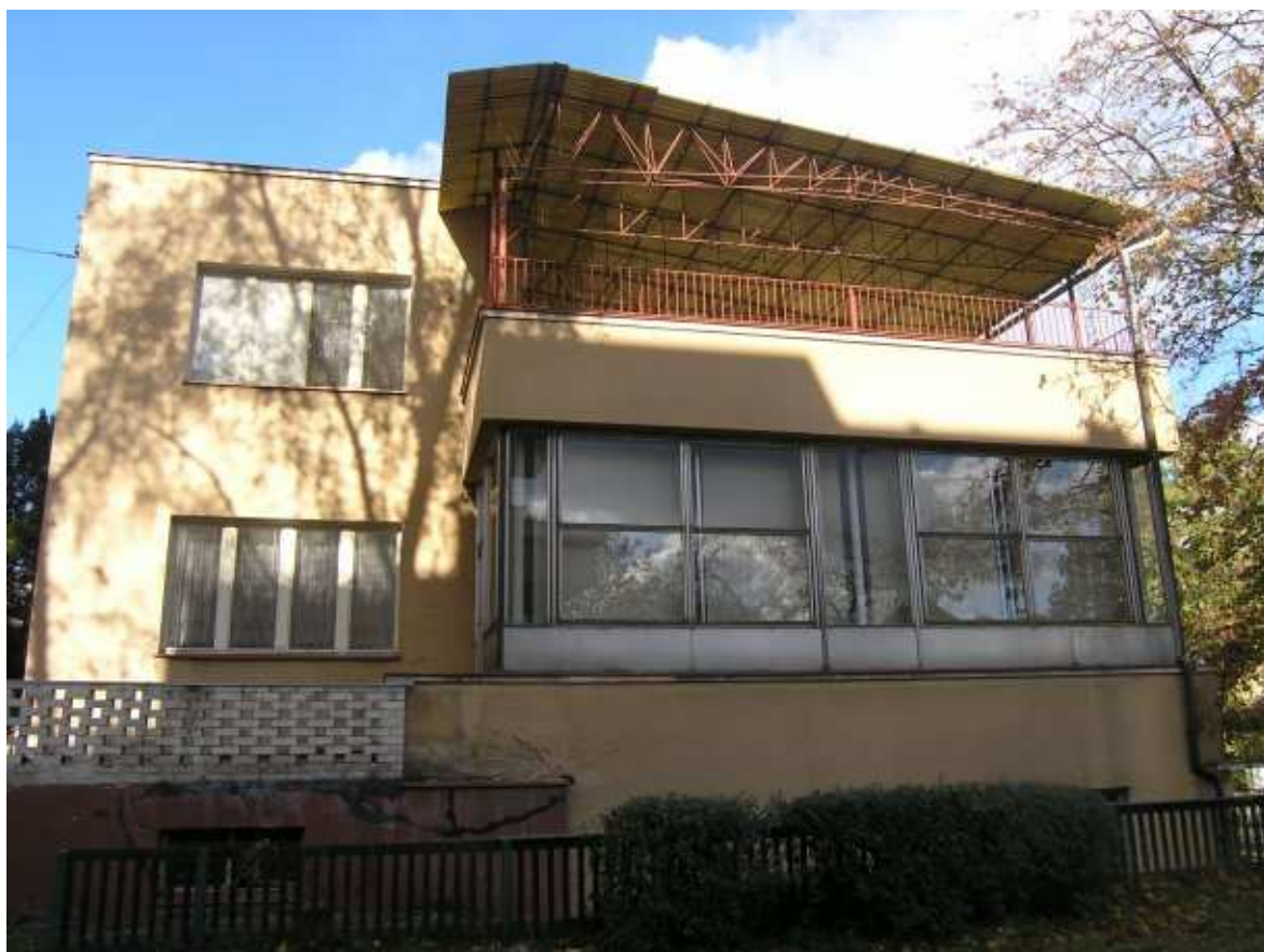
fotografie - fasáda jižní: zdroj: Matěj Páral (2006)
