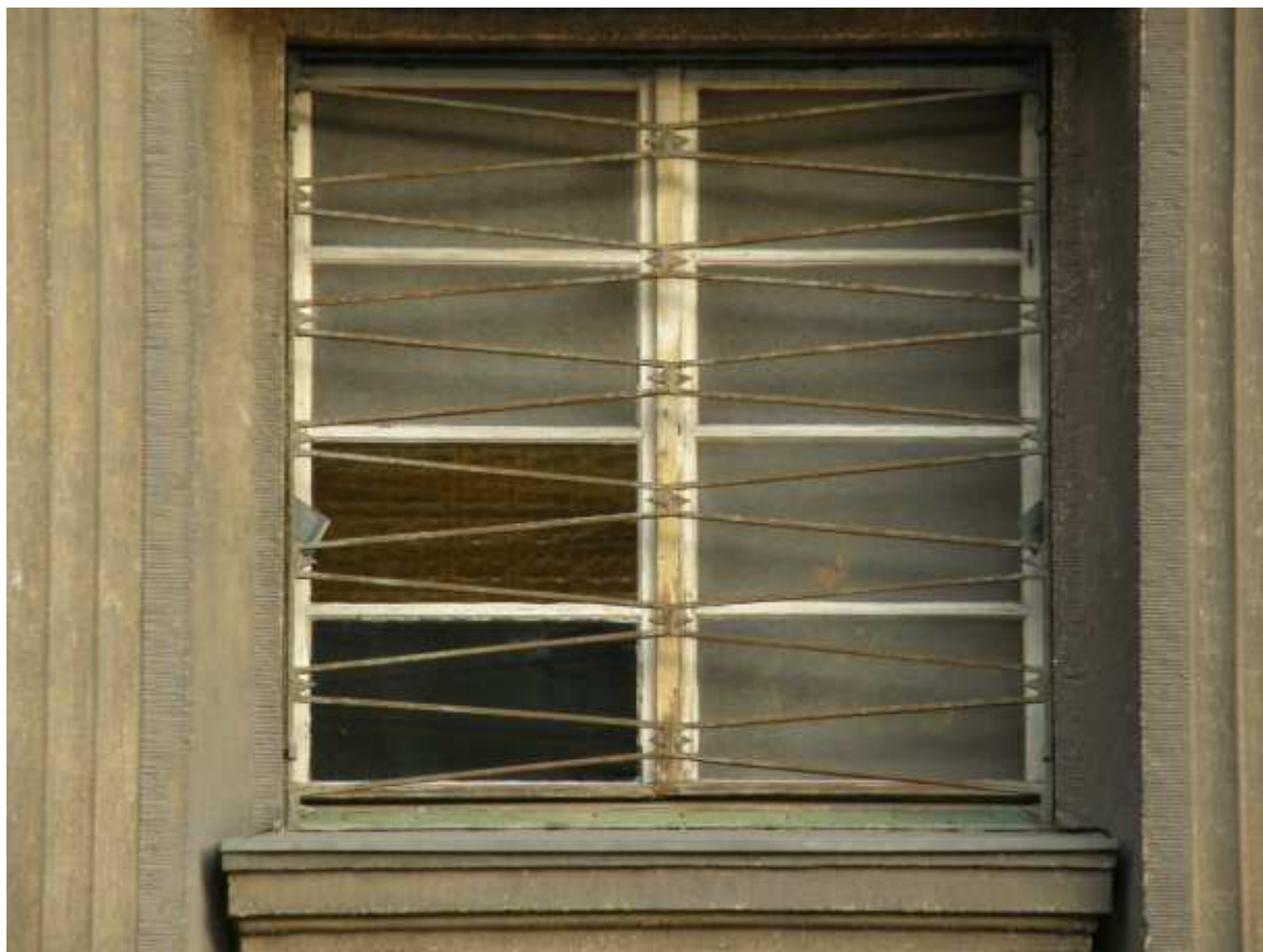
fotografie - detail schodišťového okna s mříží: zdroj: Matěj Páral (2008)
