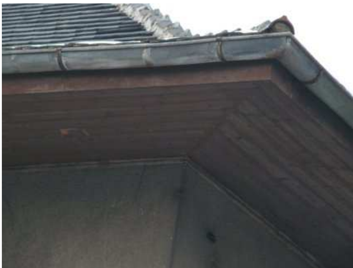
fotografie - detail římsy: zdroj: Matěj Páral (2008)
