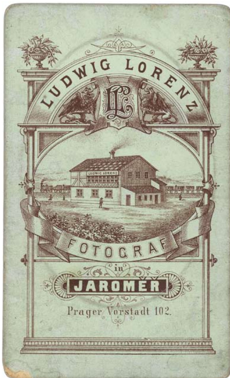
Obr. 11: Vzácný příklad vyobrazení fotografova působiště. Současně doklad o poměrně velkorysé stavbě.
