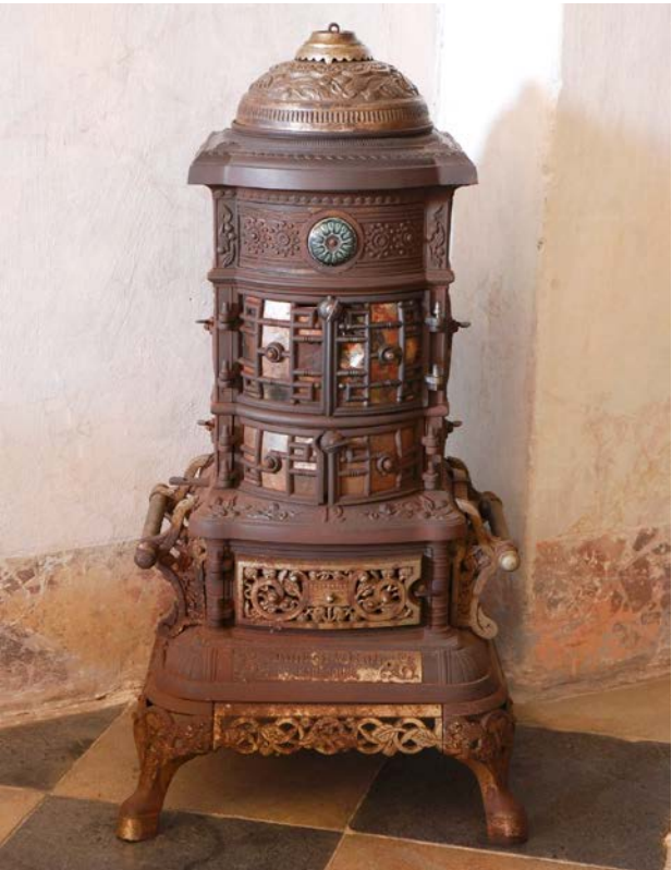
Obr. 83 Kamna, 3. třetina 19. stol., SZ Kunštát. Tzv. Americká litinová kamna s původně protikorozní úpravou tzv. poníkování, vykazují z důvodu dlouhodobého umístění v nevyhovujícím prostředí s vlivem vlhkosti a sírých par v ovzduší, stopy povrchové koroze.
