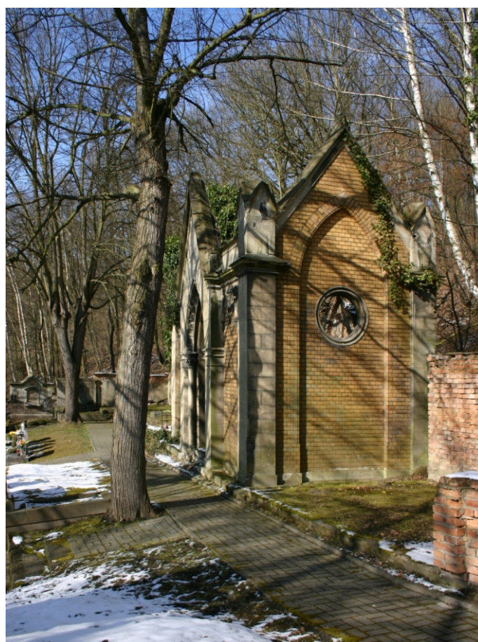
pohled od jihu
