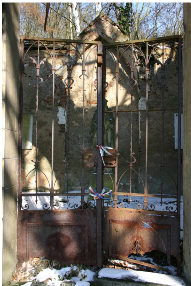
vstupní dvoukřídlá brána ze snýtované tyčoviny pohled od západu
