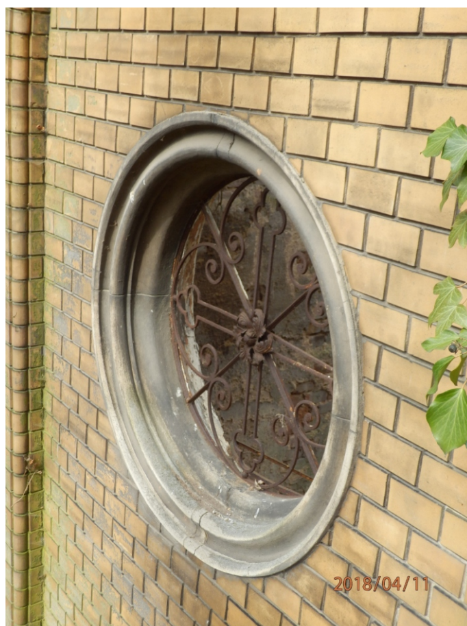
rozetové okno se šambránou a ozdobnou mříží pohled od jihovýchodovýchodu
