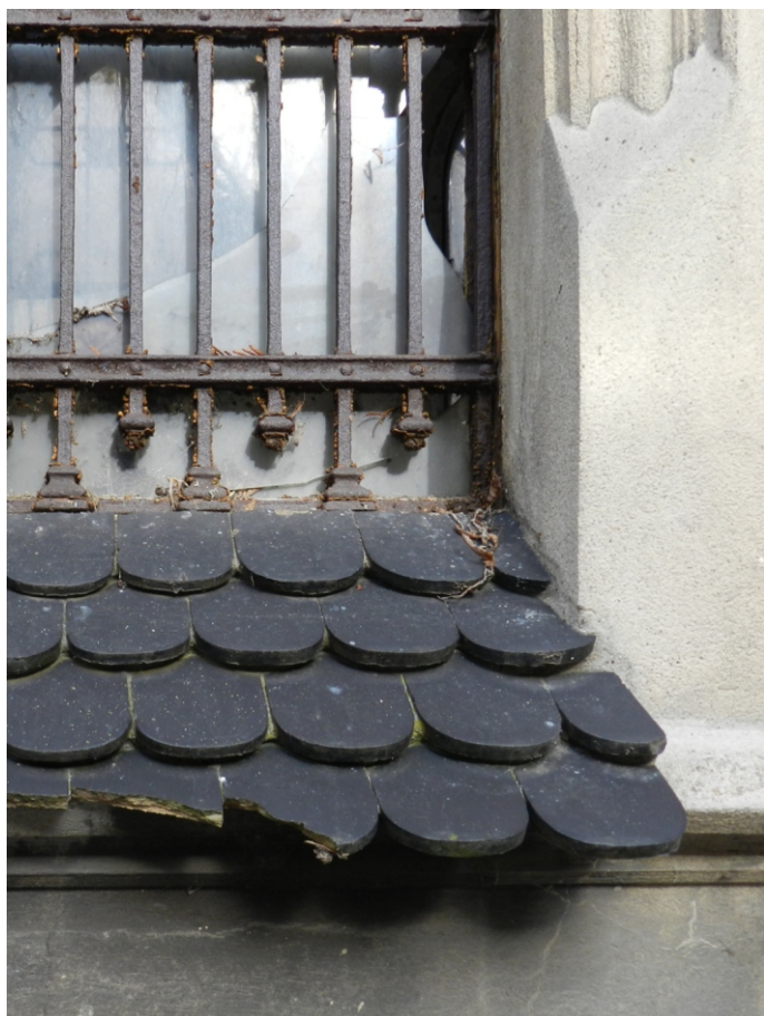
krytí parapetu bobrovkami kladenými jednoduše pohled od západu
