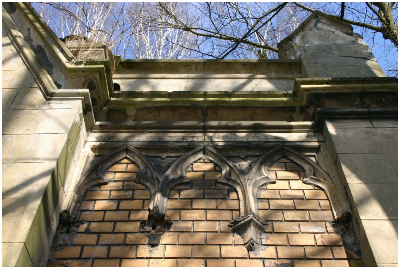
vlys pod římsou tvořený jeptiškami, vpravo vedle vstupního portálu pohled od západu
