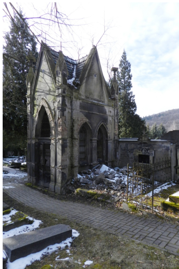
pohled od jihovýchodovýchodu
