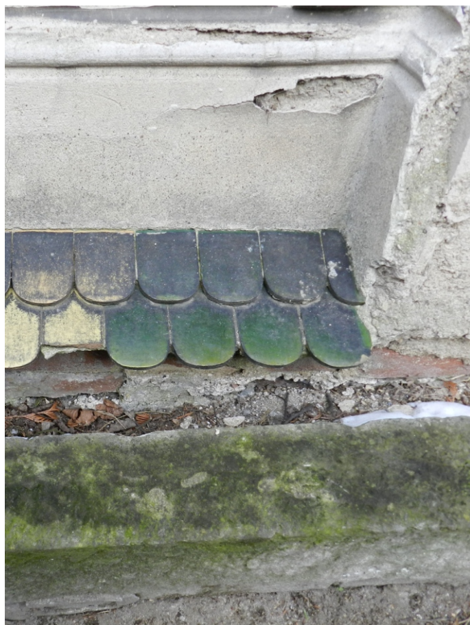
krytí soklu pod parapetem bobrovky se žlutozelenou glazurou
