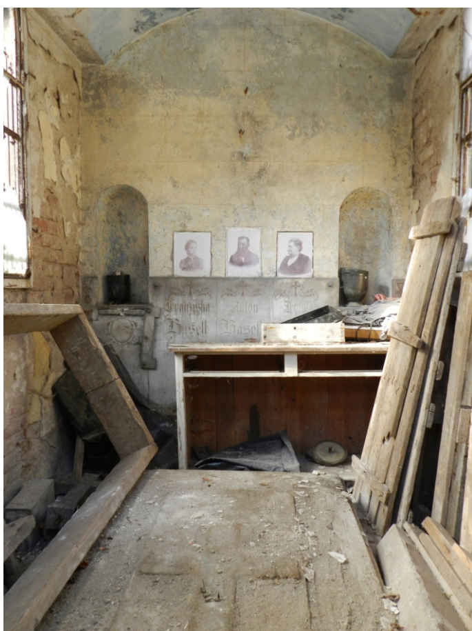
čelní stěna s nikami pro urny a s fotodobiznami nad deskami se jmény a daty
