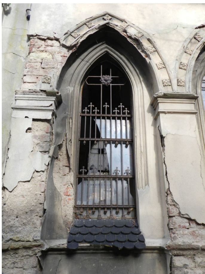
levý otvor sduženého okna západní fasády details štukových profilací a ozdobné mříže
