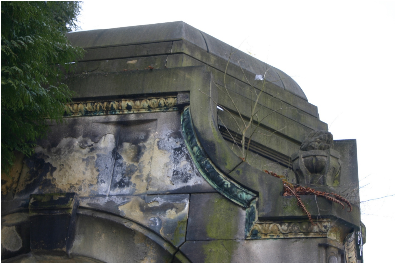
kopule baldachýnu: klenák záklenku, štítek, římsa s vejcovcem, váza, pendentiv, ustupující prstence pohled od jihu
