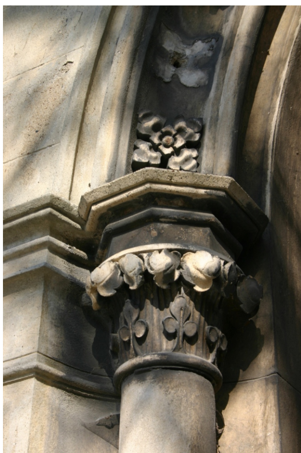
hlavice tříčtvrtěsloupu a poupata na portálu pohled od jihozápadu
