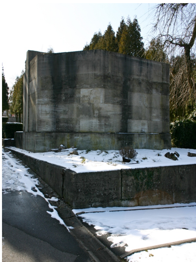
pohled od severovýchodu
