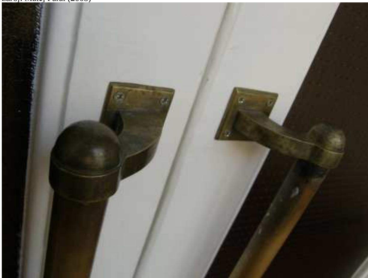
fotografie - detail zábradlí hlavního schodiště: zdroj: Matěj Páral (2008)
