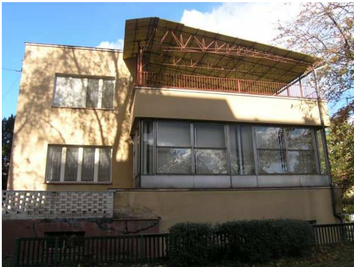
fotografie - fasáda jižní: zdroj: Matěj Páral (2006)
