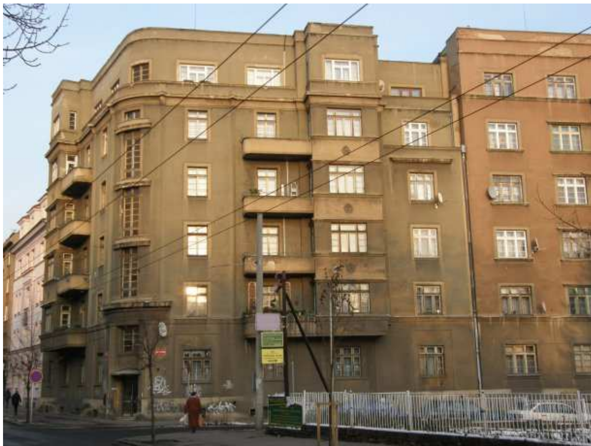
fotografie - průčelí: zdroj: Matěj Páral (2008)
