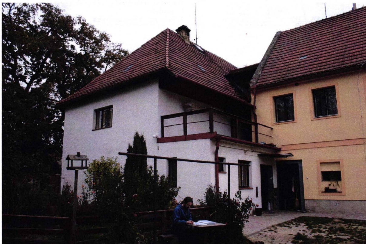
novostavba domu čp. 2 na místě původního domu čp. 2 – stav v říjnu 2005 (vpravo část hospodářského objektu)
