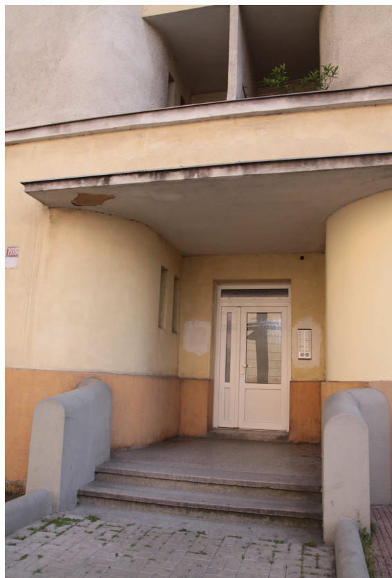
▼ západní fasáda, detail vstupu
