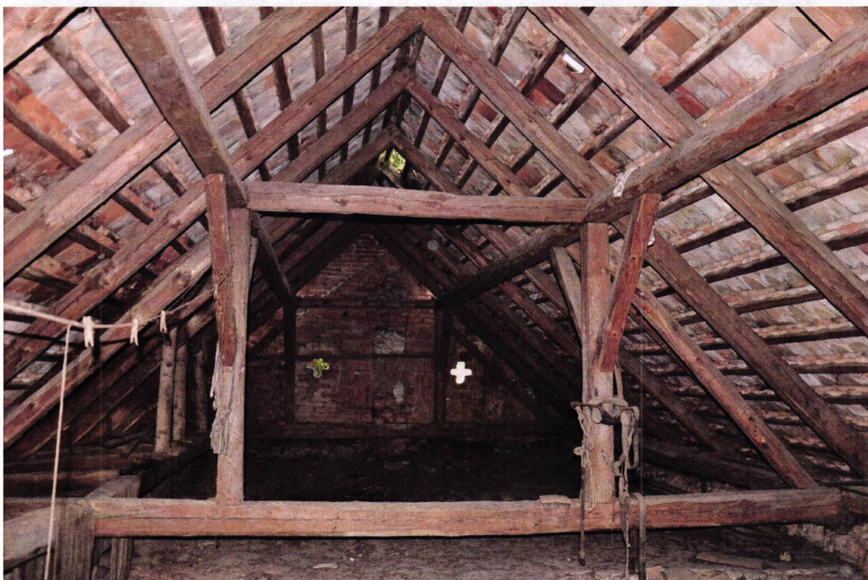
krovy nad obytnou částí
