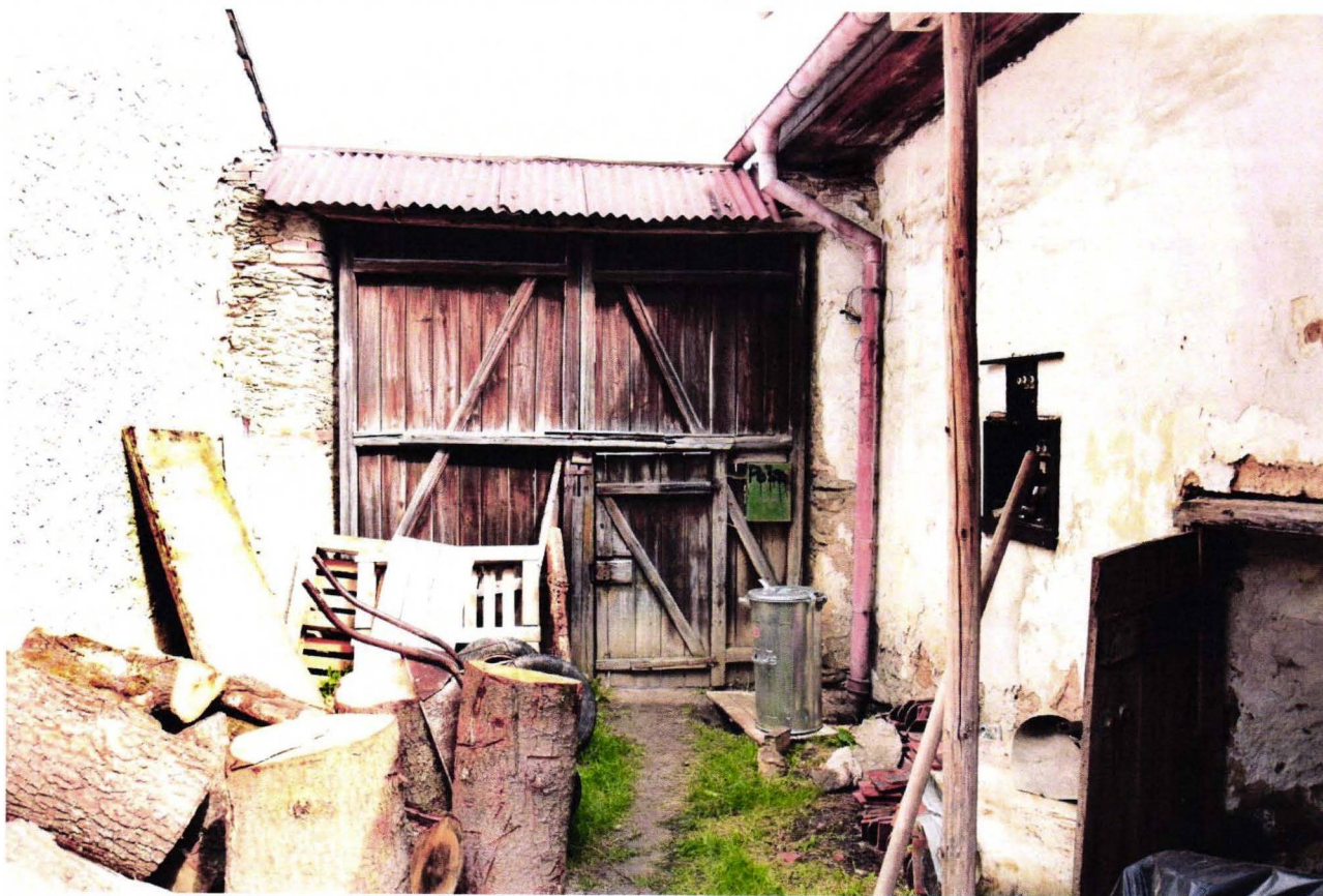
Pohled na vstupní vrata z dvorní strany
