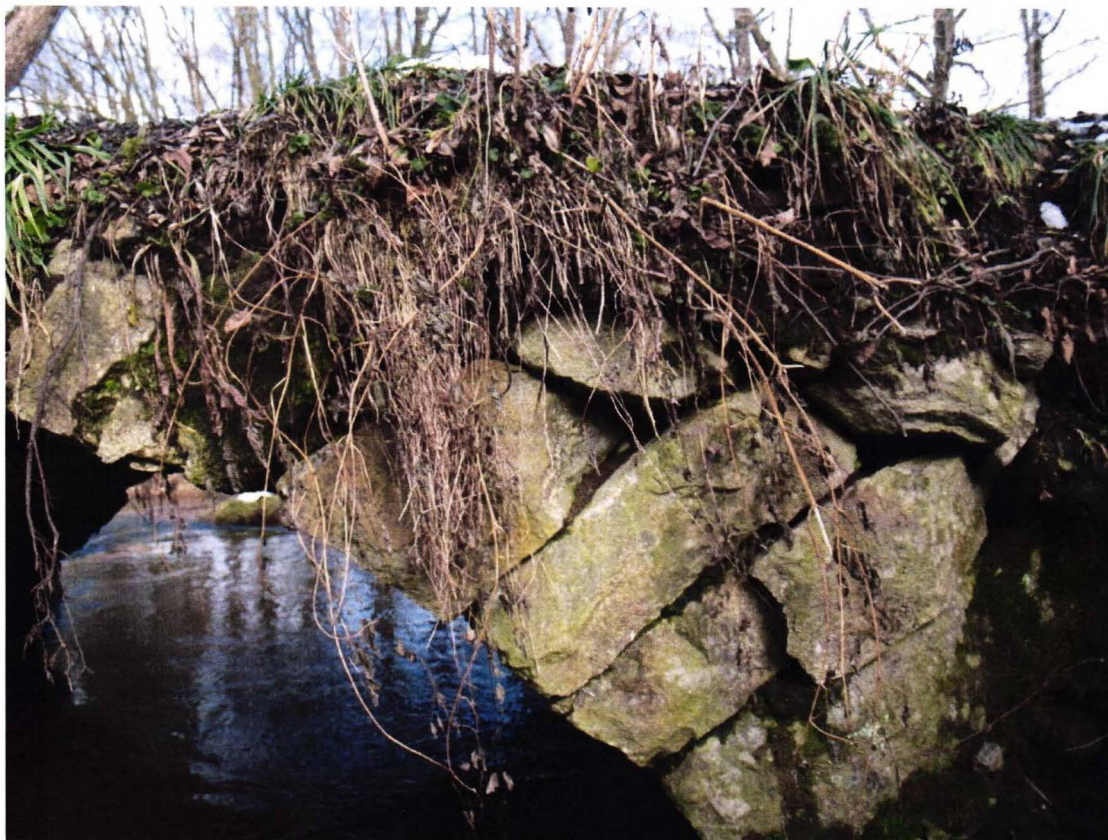
3. KP – pohled na zasazení klenáků, detail
