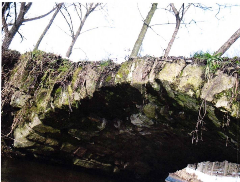
2. KP – pohled na konstrukci kamenného klenutí mostku
