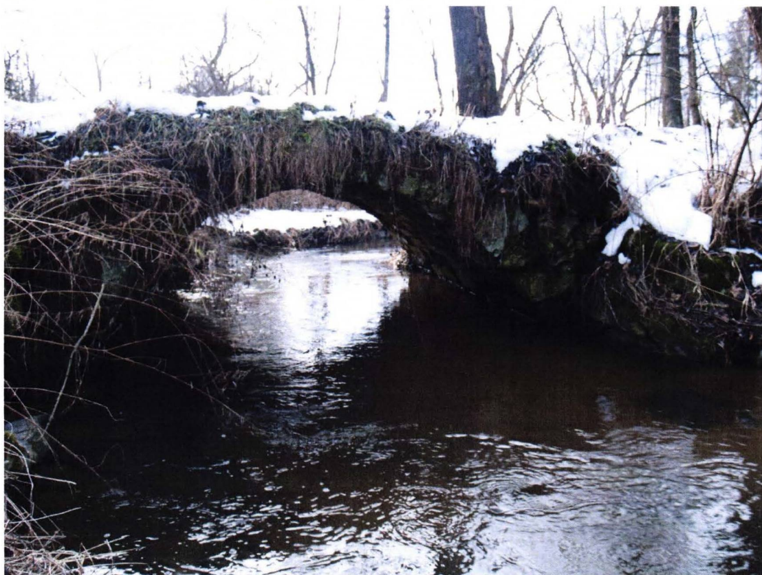
4. KP – severní mostek, Pěčín - pohled z druhé strany
