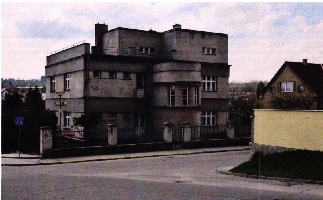
1. KP – stavba Baregerovy vily, uliční pohled
