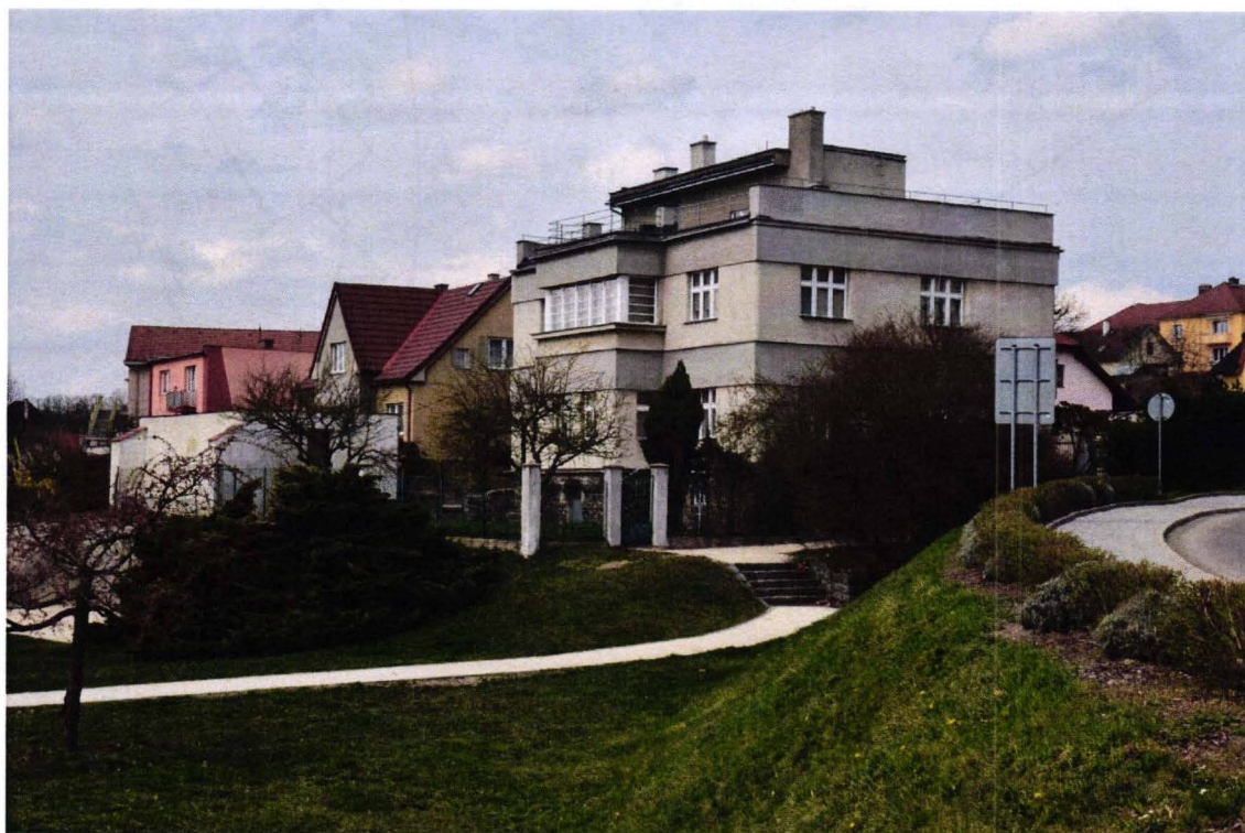
2. KP – stavba Baregerovy vily, pohled od zahrady
