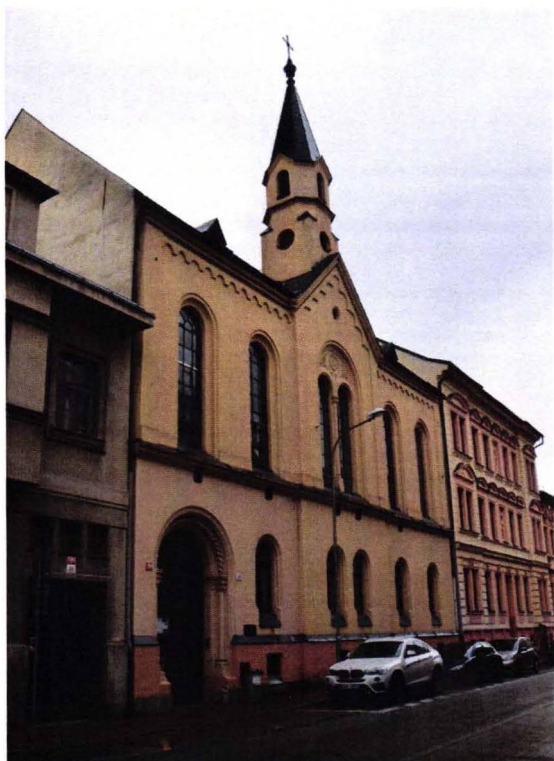
1. KP – budova modlitebny č. p. 1306
