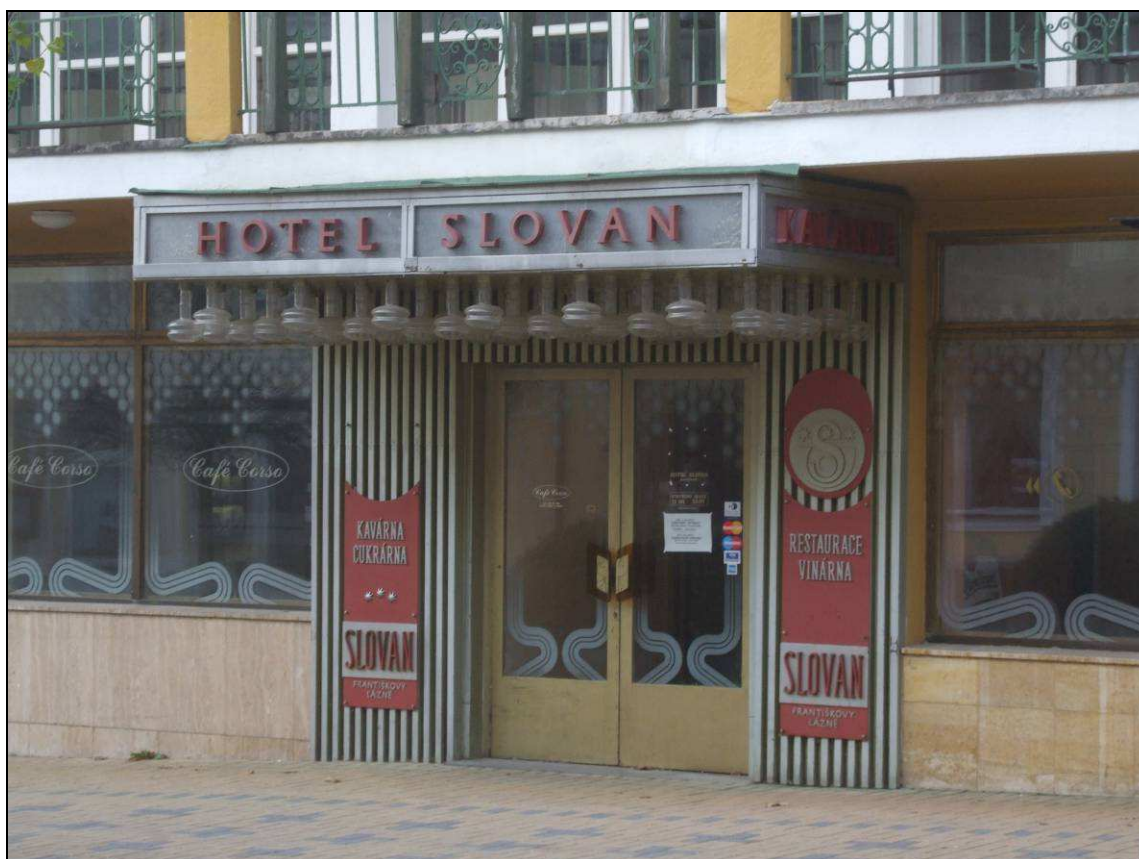
Františkovy Lázně, Národní třída č.p. 6, hotel Zlatý anděl – detail hlavního vstupu do objektu
