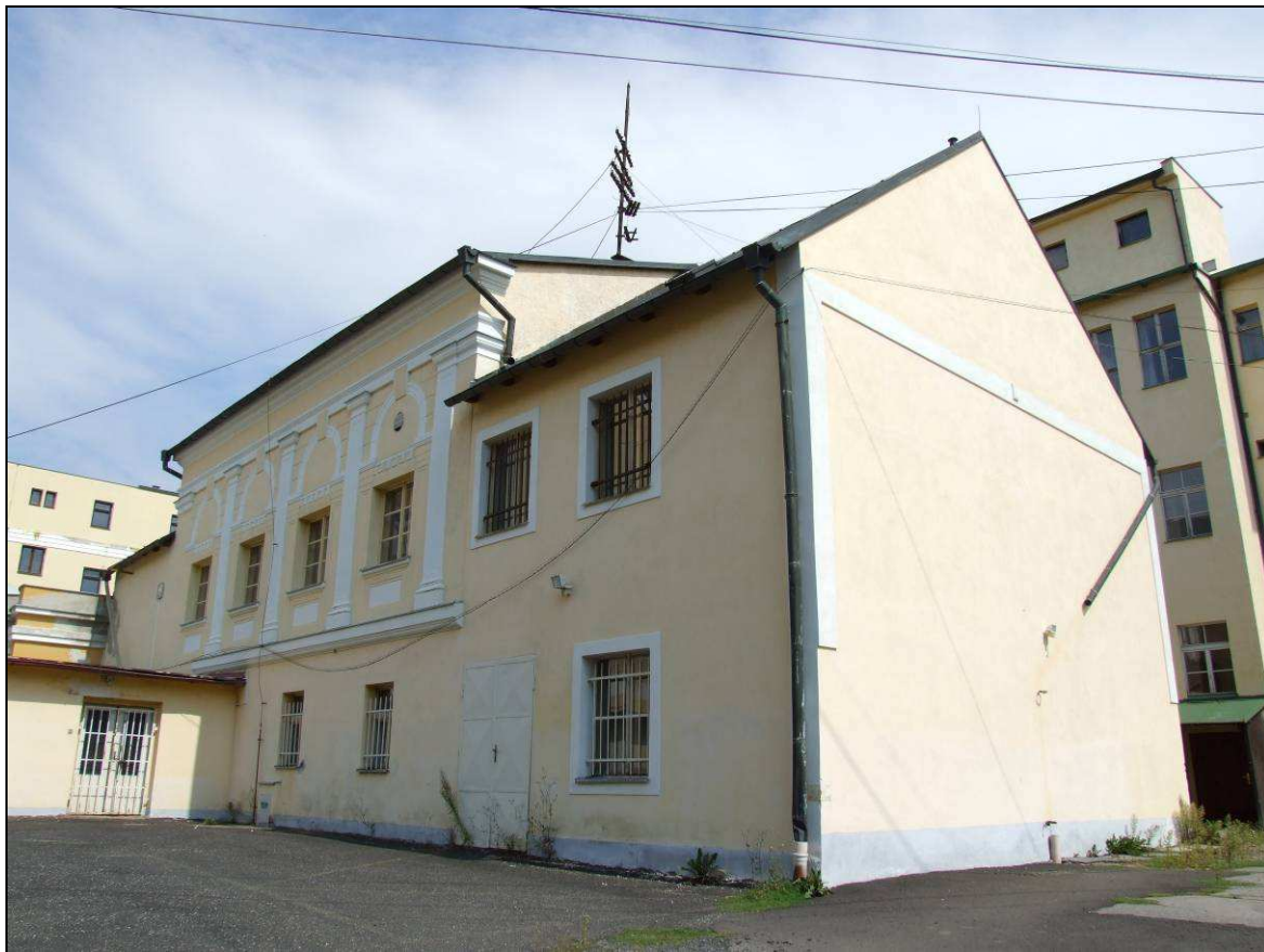
Františkovy Lázně, Národní třída č.p. 6, hotel Zlatý anděl – celkový pohled na dvorní křídlo s tanečním sálem v patře od JZ
