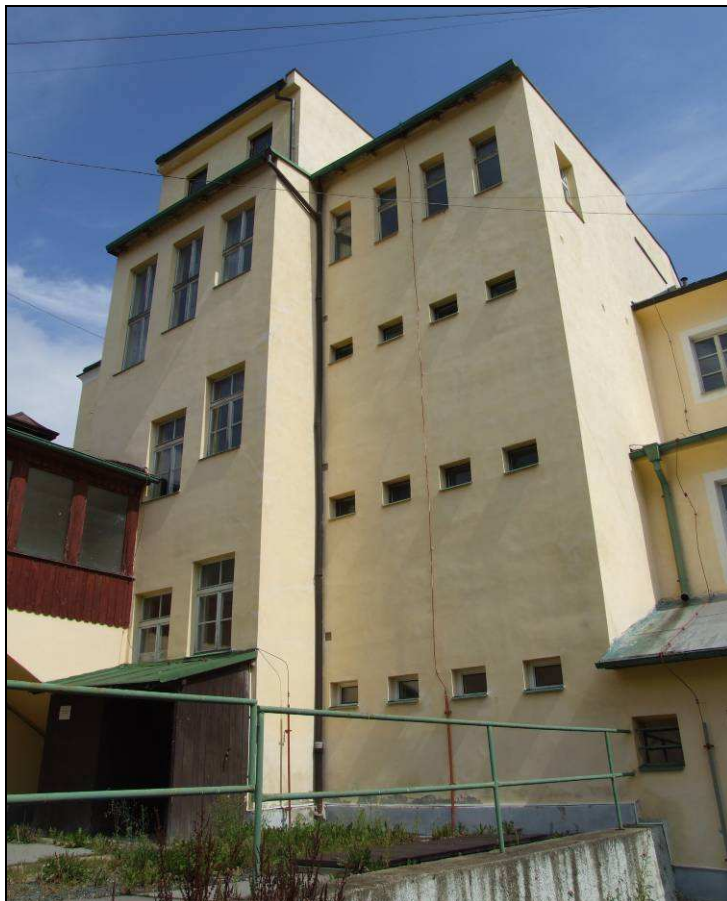
Františkovy Lázně, Národní třída č.p. 6, hotel Zlatý anděl – pohled na zadní průčelí hlavní budovy od JZ
