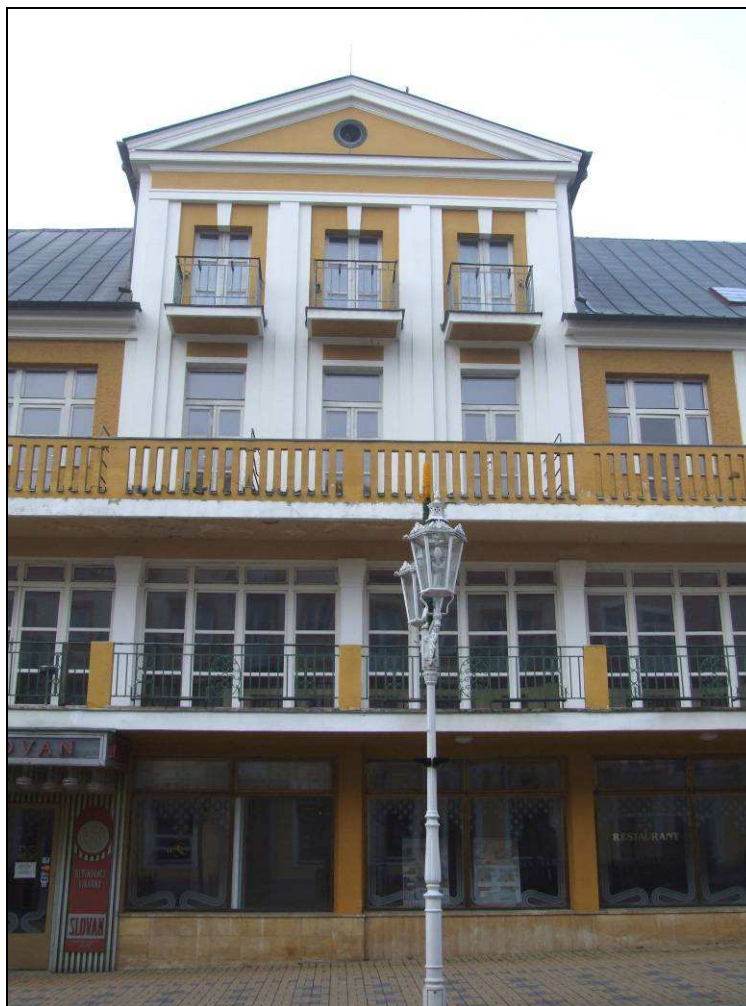
Františkovy Lázně, Národní třída č.p. 6, hotel Zlatý anděl –detail střední části hlavního průčelí
