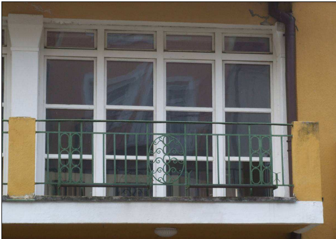
Františkovy Lázně, Národní třída č.p. 6, hotel Zlatý anděl – detail balkónu s kovovým zábradlím na hlavním průčelí
