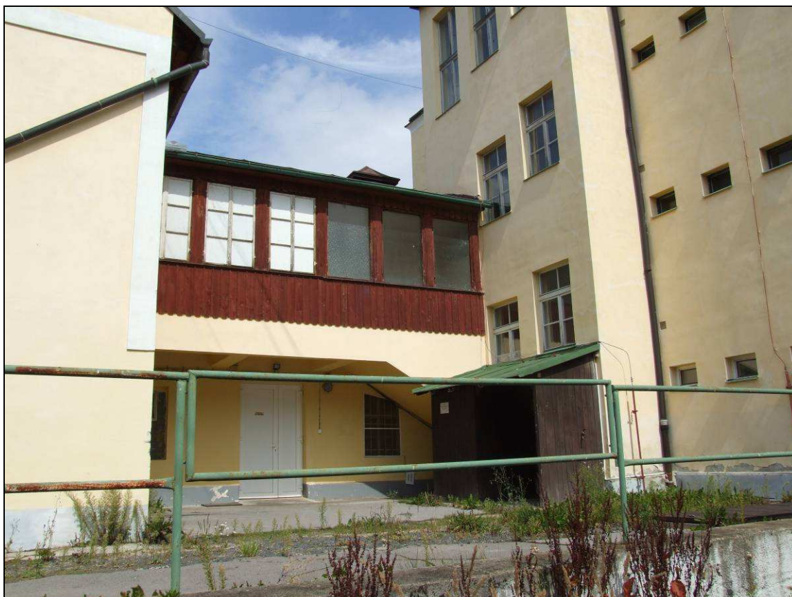
Františkovy Lázně, Národní třída č.p. 6, hotel Zlatý anděl – spojovací krček mezi hlavní budovou a dvorním křídlem
