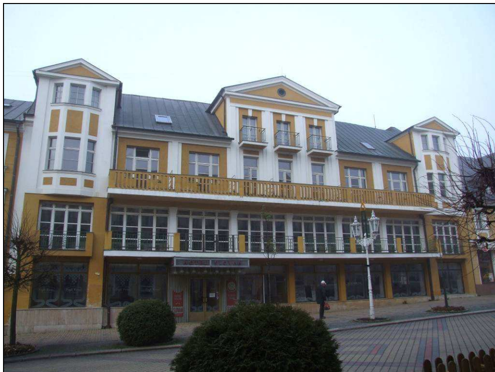
Františkovy Lázně, Národní třída č.p. 6, hotel Zlatý anděl – celkový pohled na objekt od V
