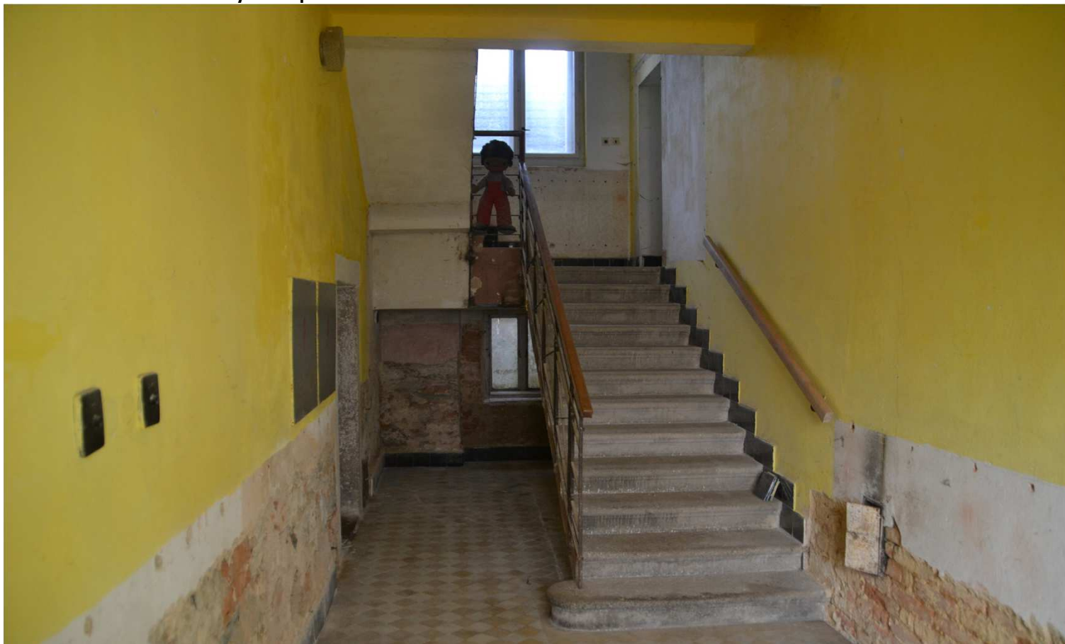
hlavní schodiště s kamennými stupni a včetně dlažeb
