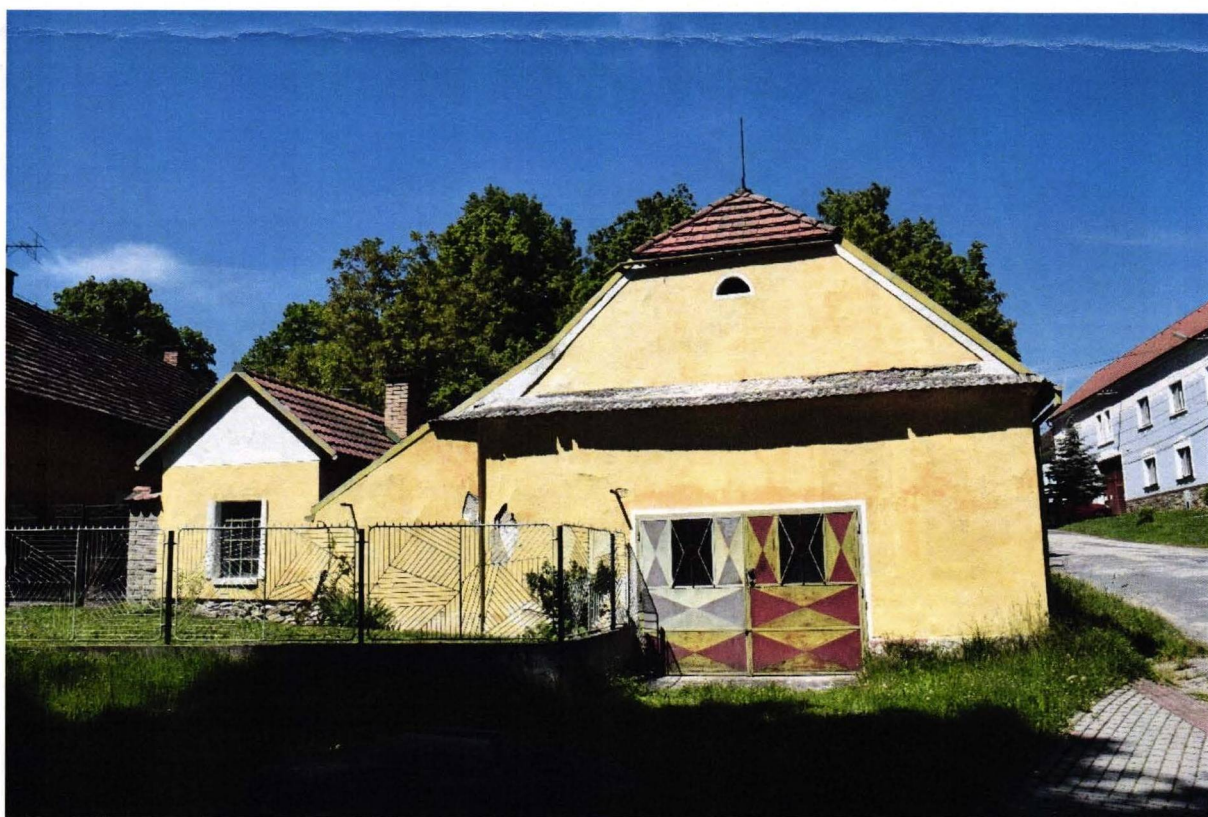
Kovárna se západním pultovým přístřeškem a hospodářská budova – pohled od jihu
