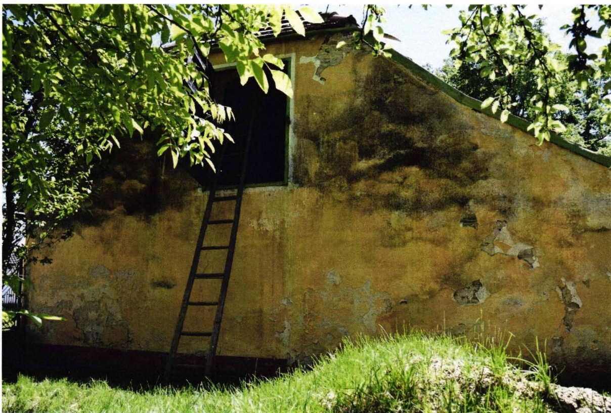
Kovárna s obydlím pro tovaryše a pultovým přístřeškem – pohled od severu
