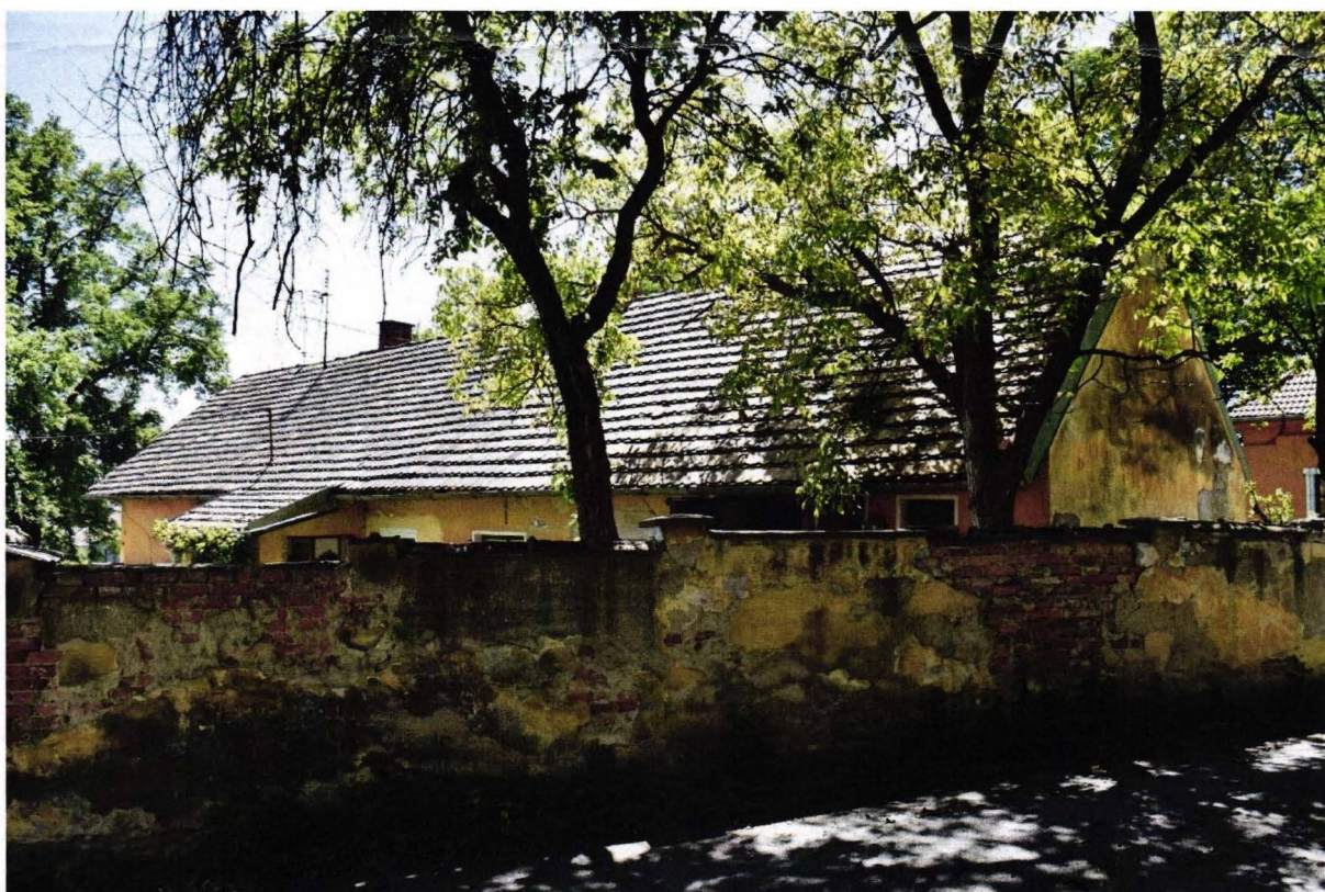
Ohradní zeď a obytná budova s hospodářskou částí – pohled od severovýchodu
