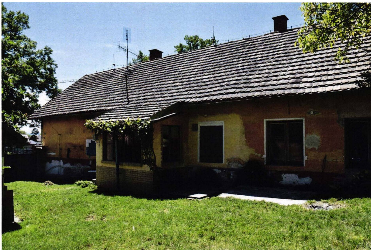
Obytná budova s hospodářskou částí – pohled od severovýchodu
