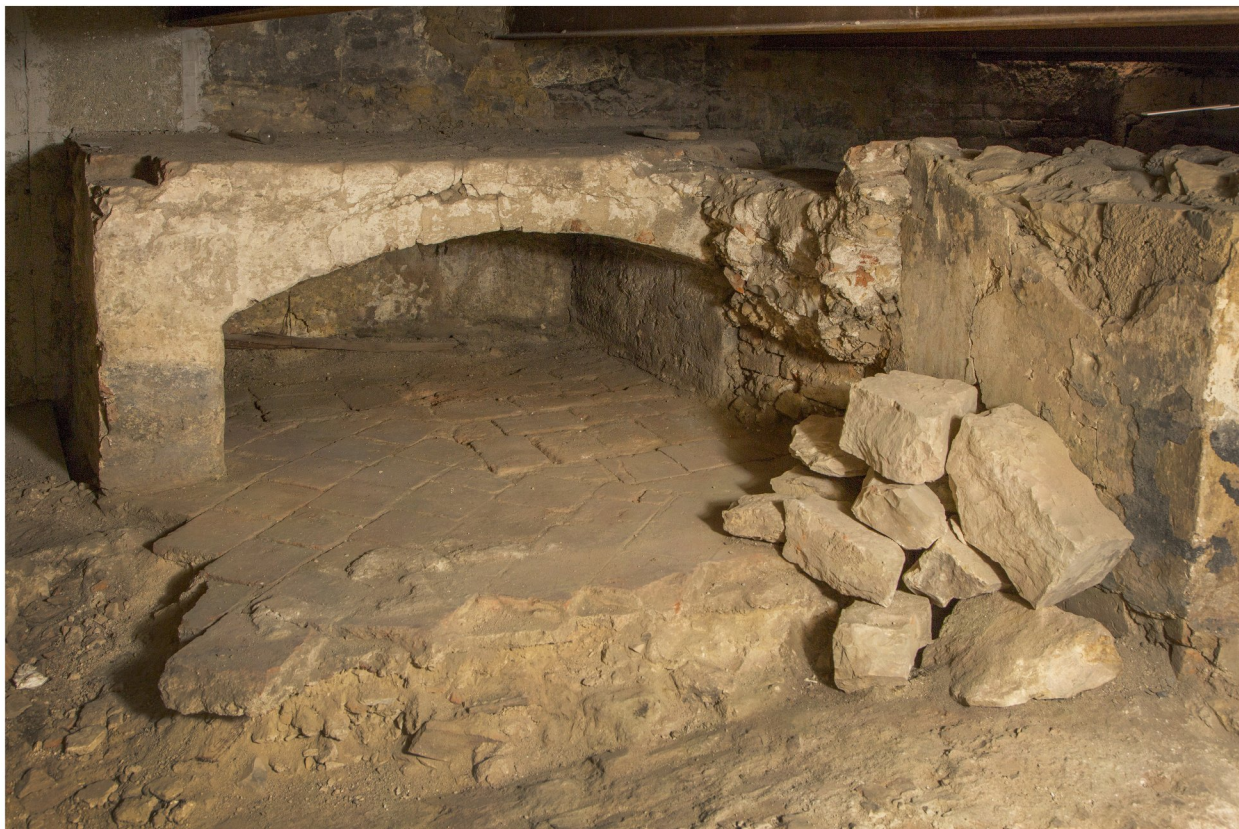
133cd_Pohled k jihovýchodu, kuchyňská podesta, dvě fáze ker. dlažby. V jižní stěně (vpravo) zdivo pod schodišťovými stupni v prostoru 132. _PH IMG_0576
