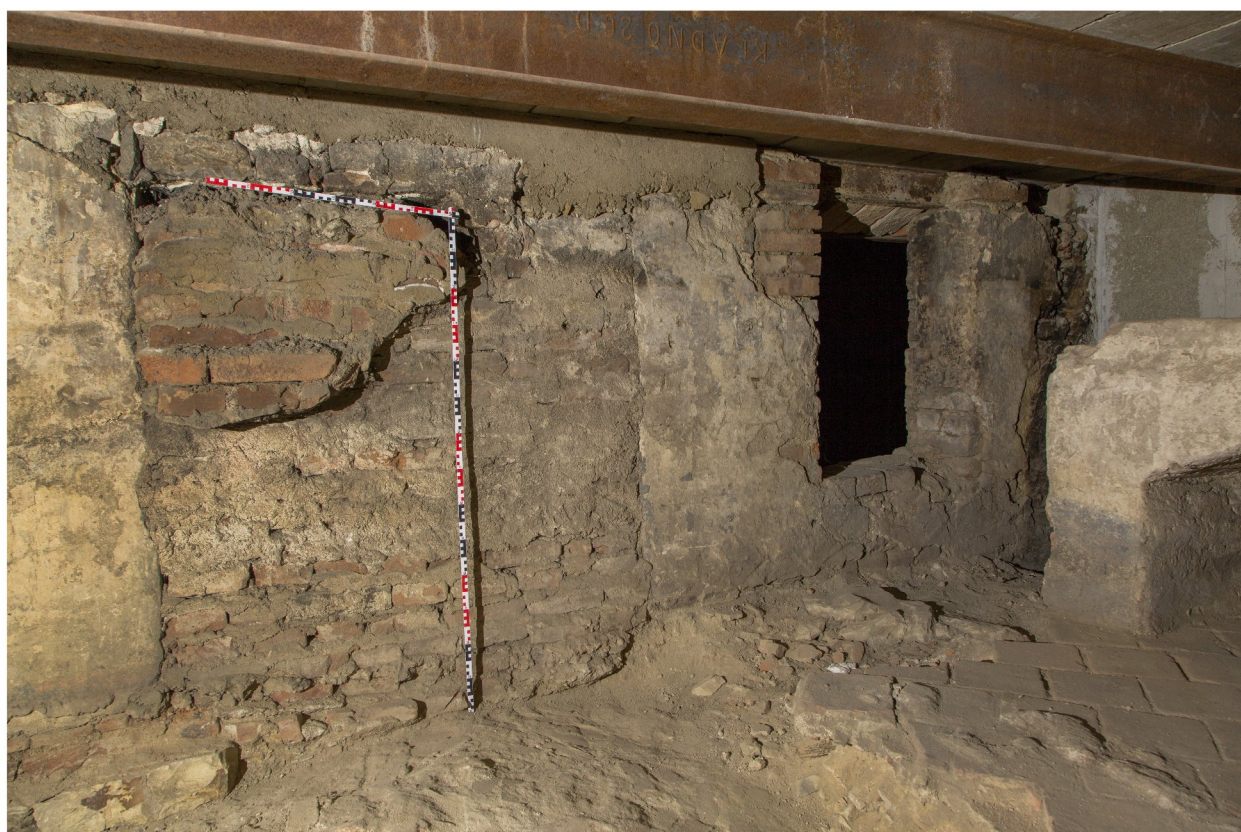
133a_ Severní stěna, východní polovina. Zazdívka vstupu do světnice 134 s pozdější opravou._PH IMG_0578
