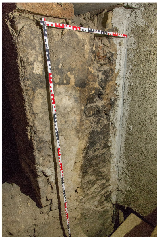
133b_kout s komínovým průduchem v parcelní zdi (za heraklitovou deskou) a nezřetelnými stopami po dymníku_PH IMG_0579
