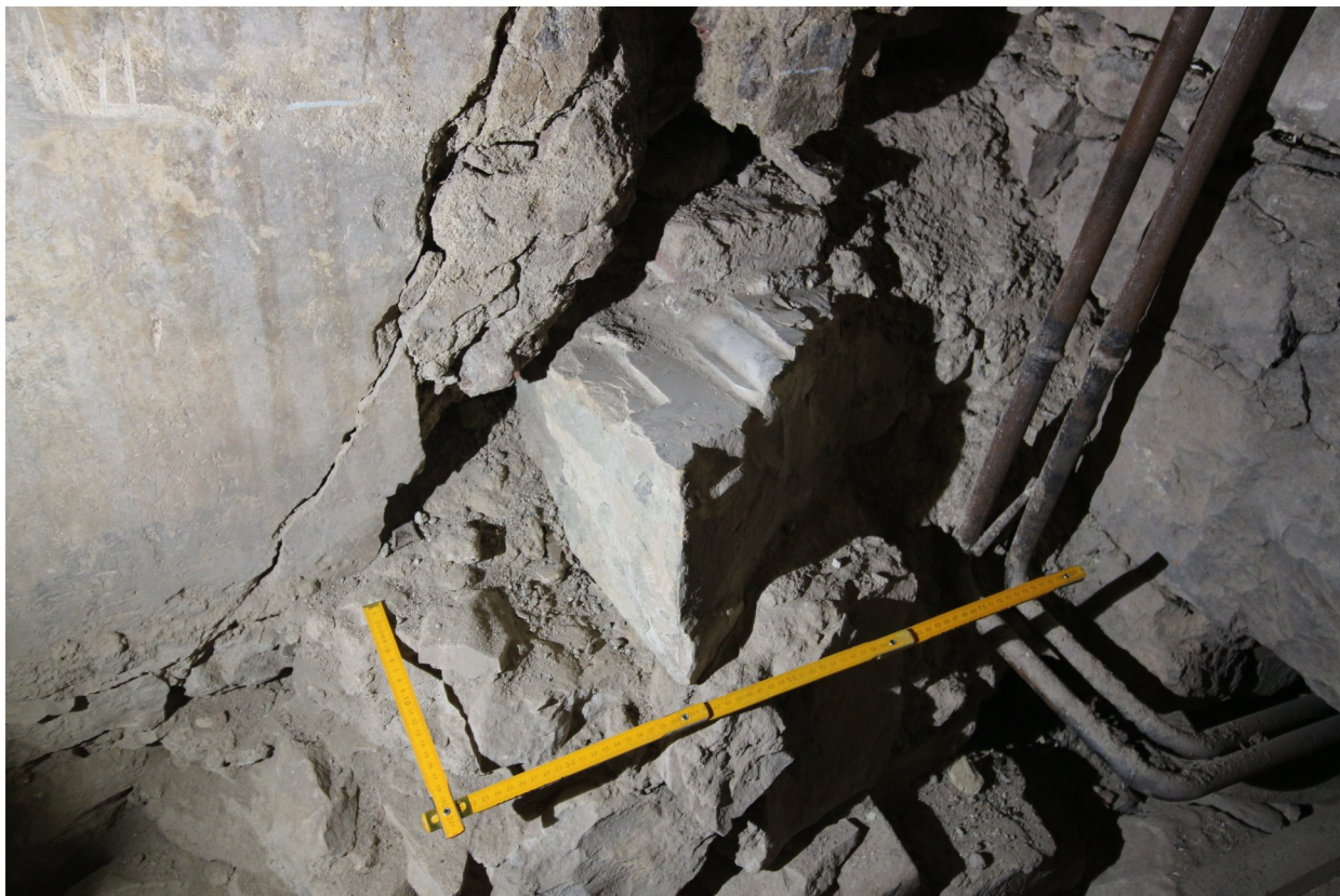
133e_západní stěna, východní polovina_PH IMG_0747 (2)
