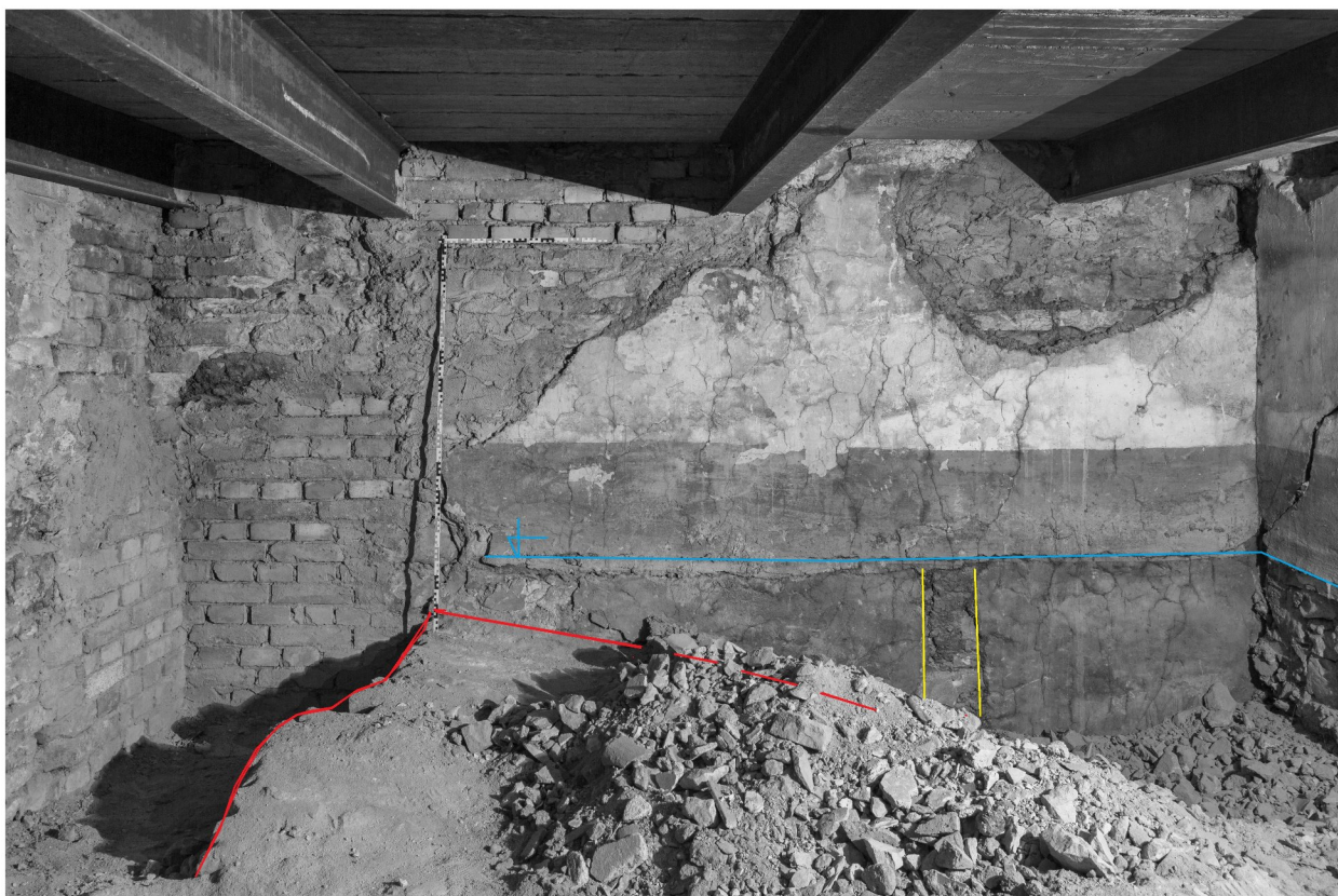
135c_V stěna. žlutě negativ sloupku či příčky, modře úroveň podlahy dřevěného patra, červeně rub stoupající klenby černé kuchyně, vlevo topeništní kout
