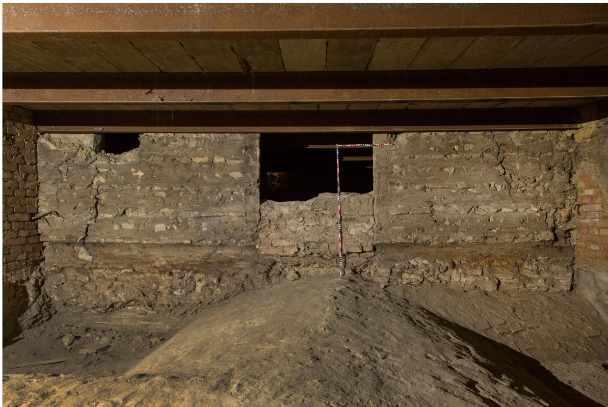
134a_Severní stěna s otisky dřevěné srubové konstrukce světnice_PH IMG_0562
