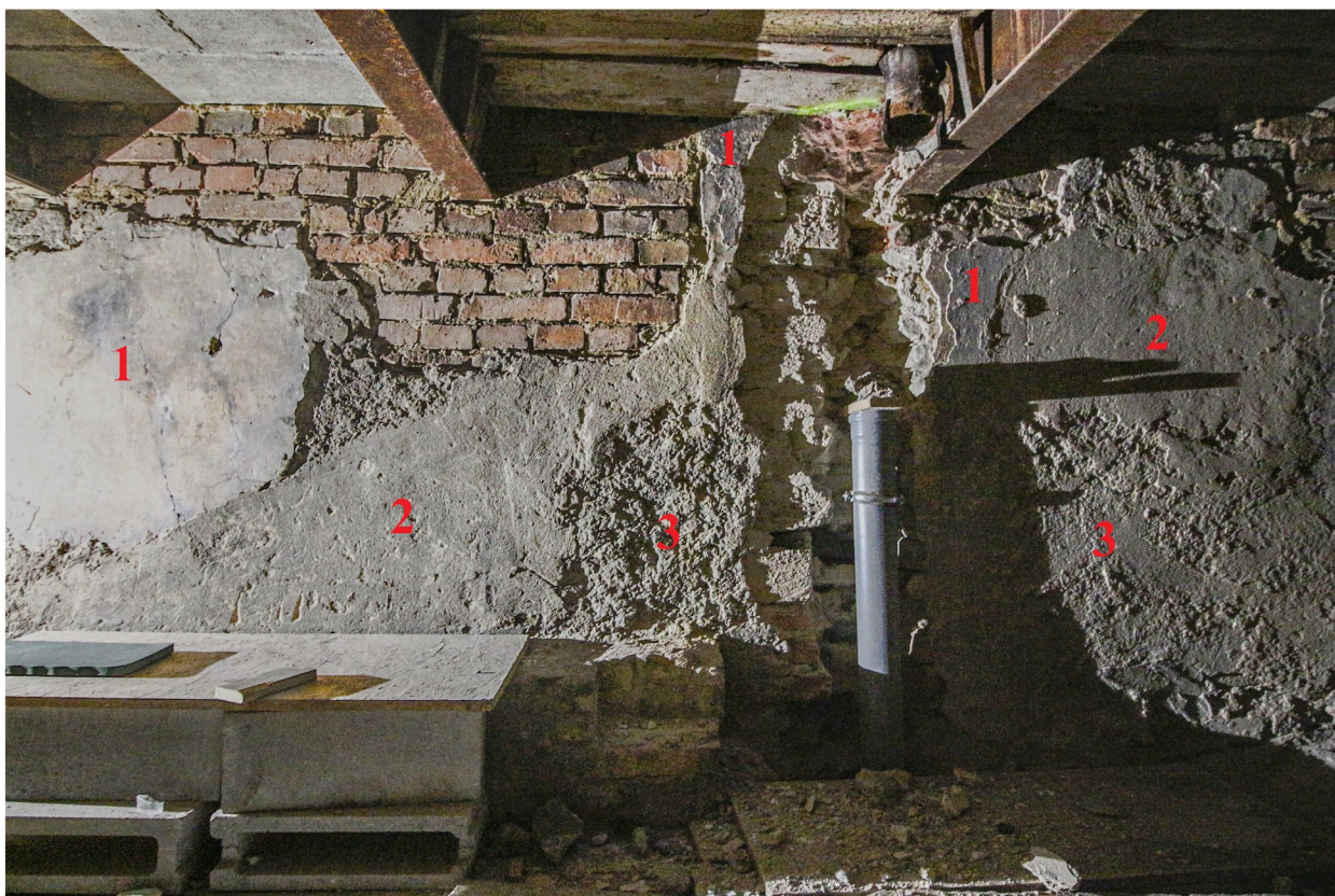
130b_střední část východní stěny e_KK IMG_2197up
