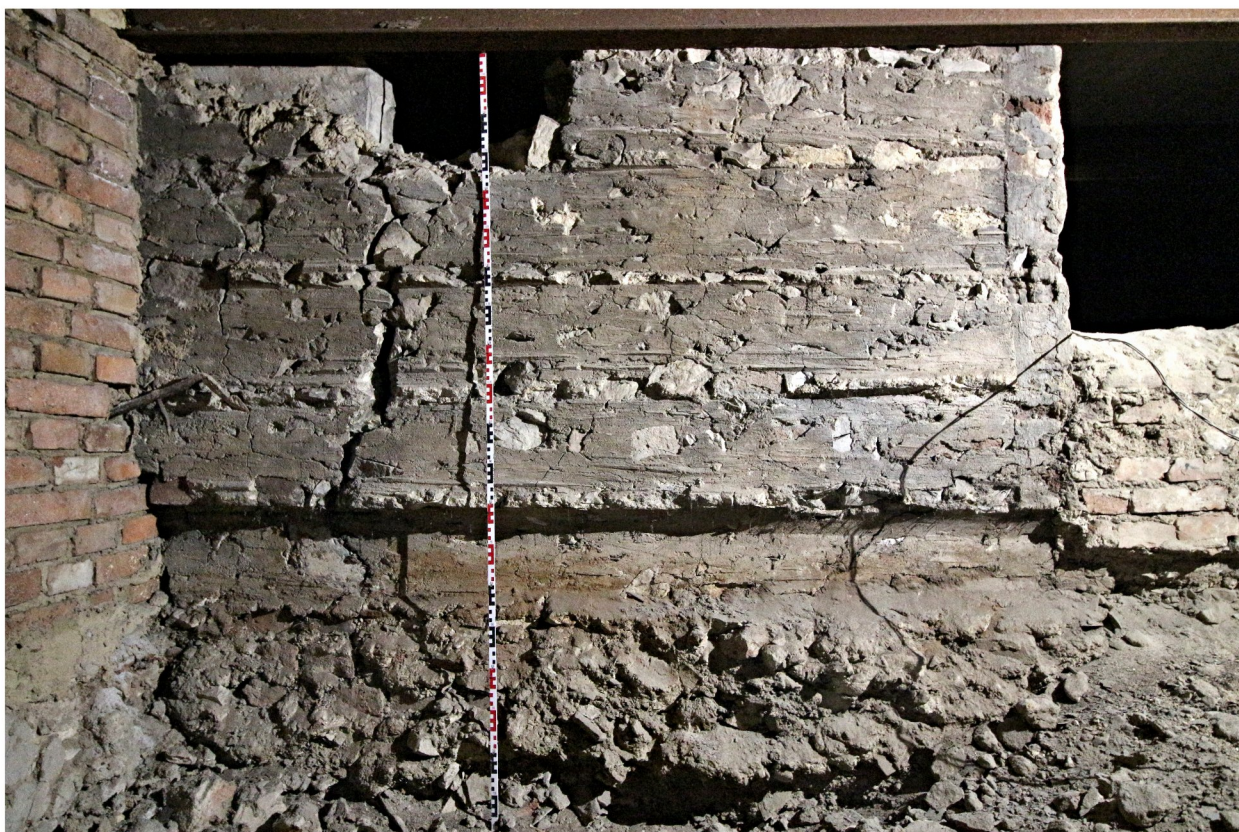
134a_Severní stěna, detail otisků neúplně hraněných trámů srubové konstrukce, patní trám o něco mohutnější_LB IMG_1156u
