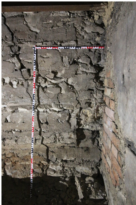
134a_SV kout s otisky čel trámů v nárožní vazbě_LB IMG_1166
