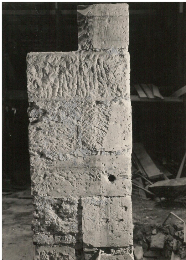
132d_nad_boční zed' schodiště v úrovni 1. patra_J_SÚRPMO 1963__D4
