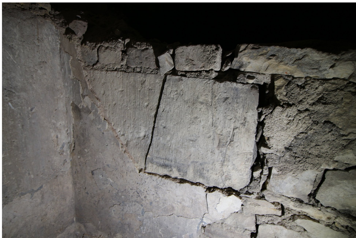
130c_druhotně použitý opracovaný kvádr s obvodovou stezkou_LB IMG_1104
