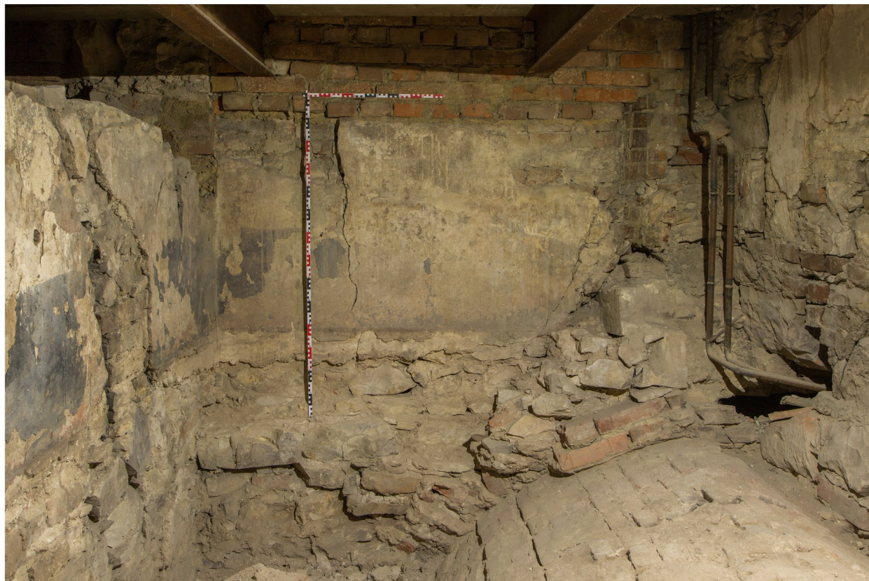
133e_západní stěna_PH IMG_0745
