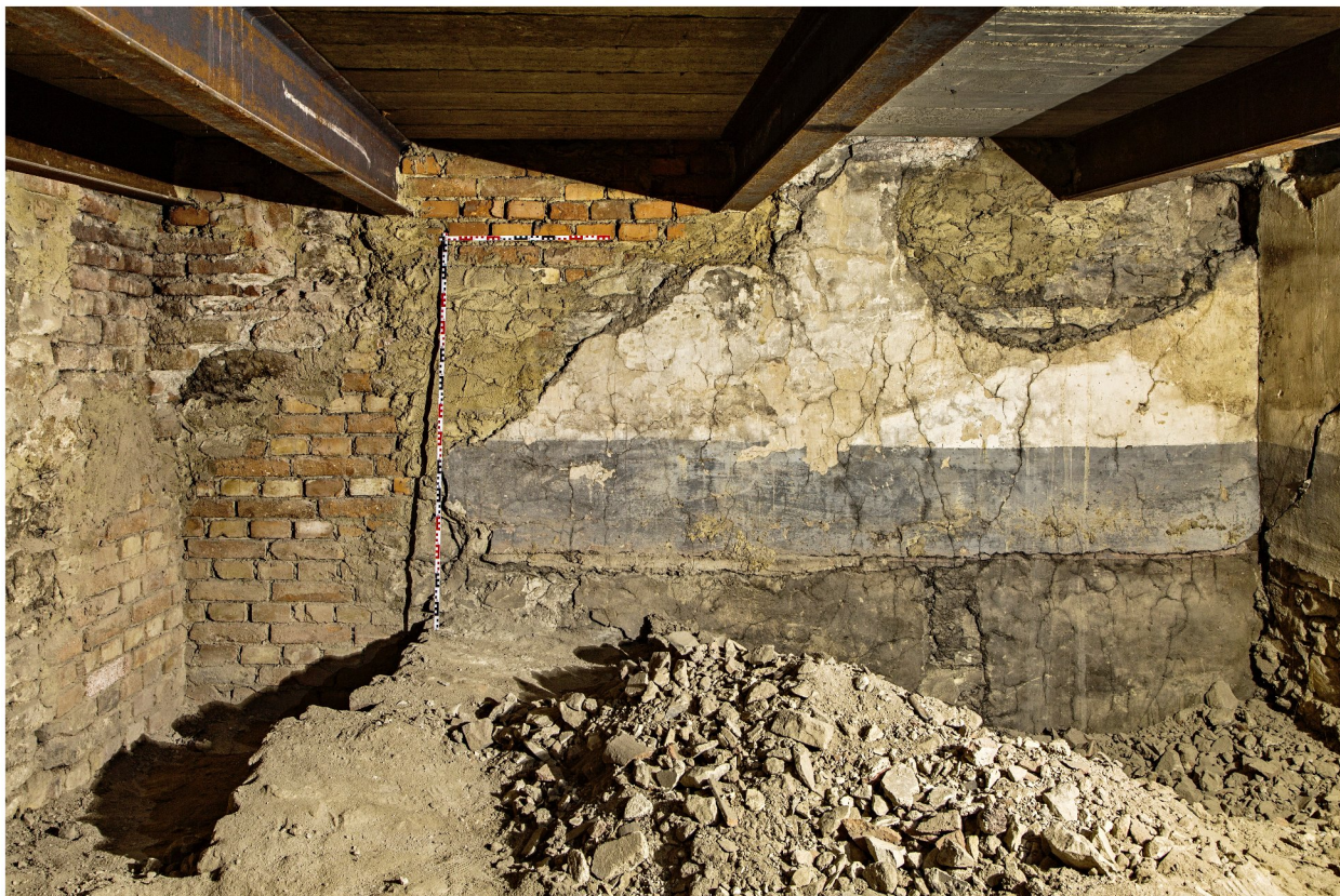
135c_V stěna s negativem konstrukce (částečně) dřevěného patra, vlevo topeništní kout_PH IMG_0566
