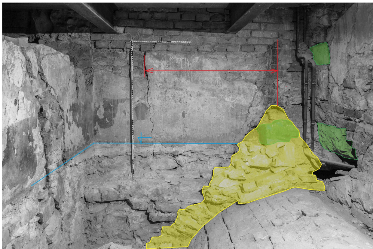
133e_Z stěna. Červeně hrana cihelné špalety, žlutě nadezdívka druh. vložené klenby, zeleně druh. použité arch. články, modře negativ podlahy _PH IMG_0745u
