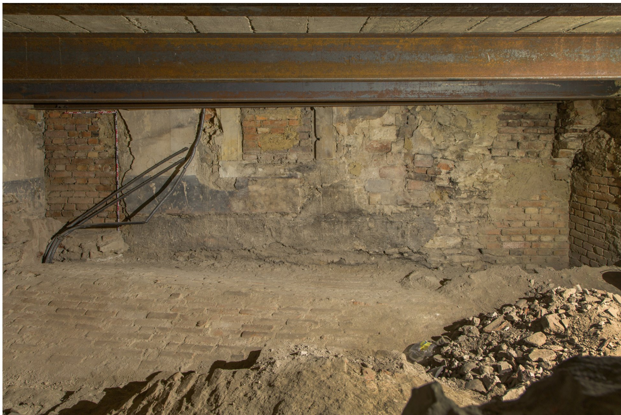
135a_Severní stěna s kvádrovanou exteriérovou omítkou, s zazděným druhotně proraženým vstupem a stopami po dymníku v SV koutě. _PH IMG_0573
