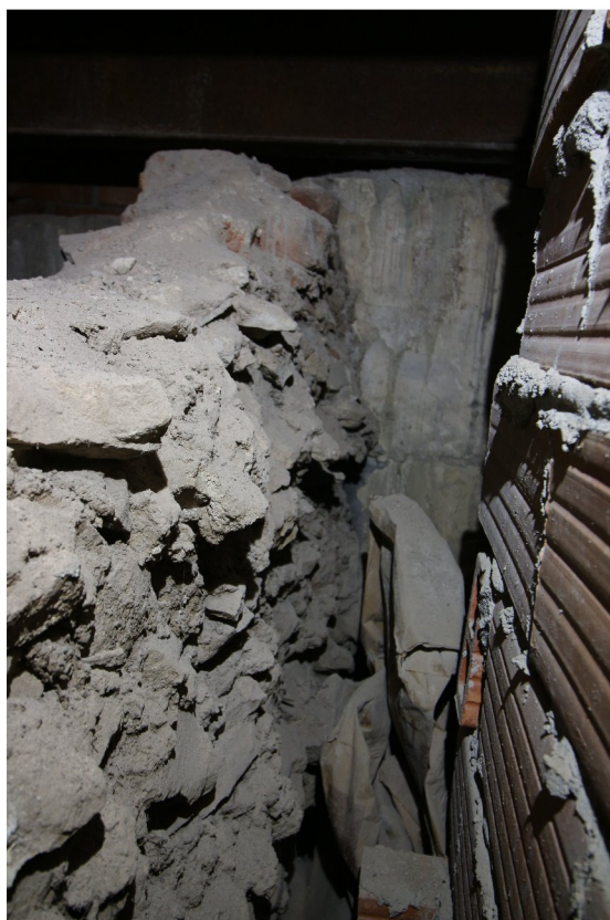
131ca_rub příčky mezi 1.30 a 1.31, vzadu omítaná strana kvádrové zídky 1.32c_KK IMG_2274
