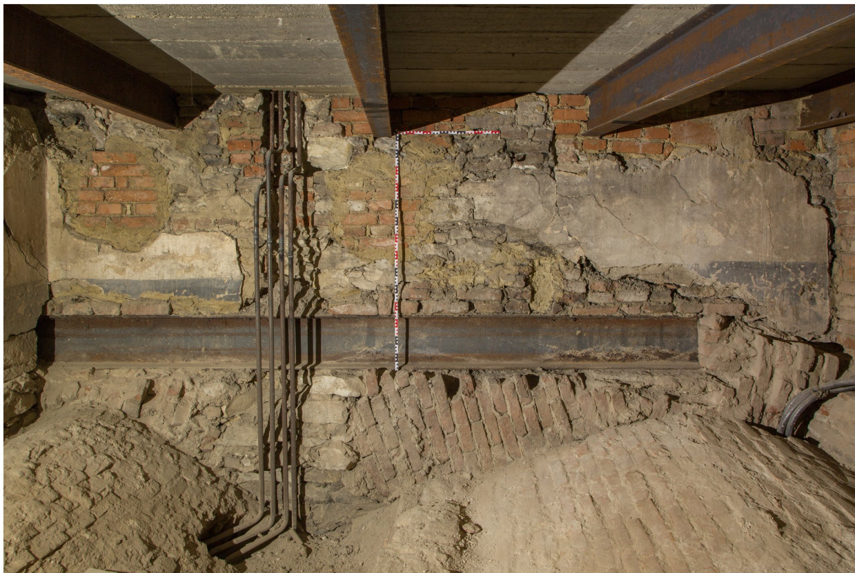
135e_Z stěna_PH IMG_0568
