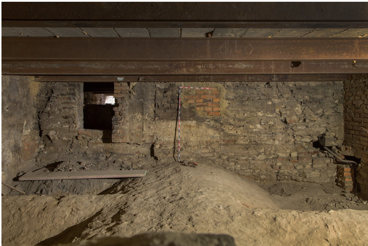
134c_jižní stěna s negativem dřevěné světnice z hraněných trámů, uprostřed zazdívka vstupu_PH IMG_0563
