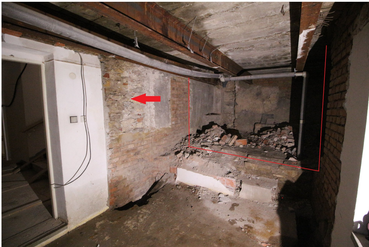
129b_ Průhled k JZ do 130 přes ubouranou příčku. Pod ubouranou plentou TZB šachty fragment staršího zdiva _LB IMG_1091
