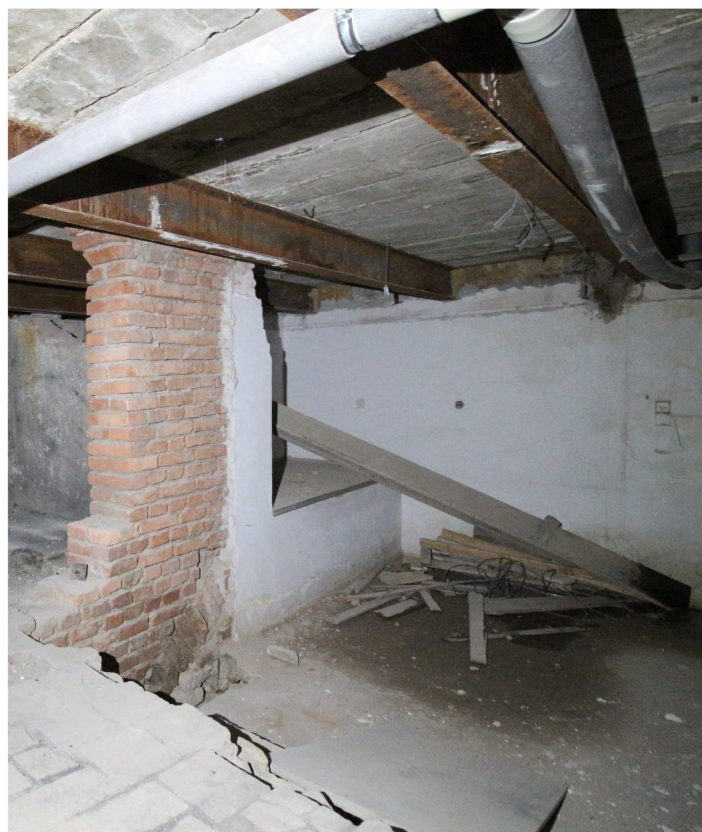
129_ Pohled k SV z 130, novodobá příčka vystavěná na odhalené čelo křížové klenby místnosti 022-023 v přízemí_KK IMG_2187
