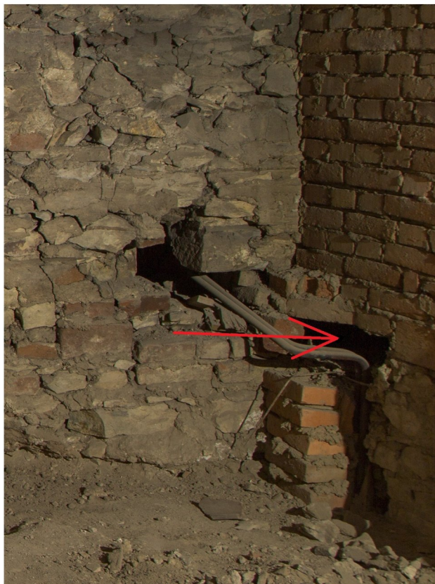
135e_JZ kout, za cihelnou plentou je obtížně viditelný bílený záklenek a pravá špaleta otvoru.PH IMG_0563v
