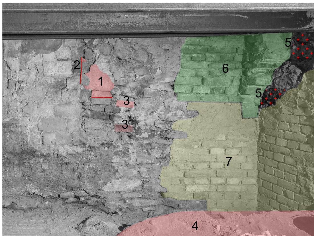
135b_1-fragm. omítky s vodorovným náběhem, 2-svislý otisk, 3-odsekané cihly předstupujícího sopouchu, 4-rub stoup. klenb,y 5-začouzení, 6-klasicist. úprava, 7-novod. oprava
