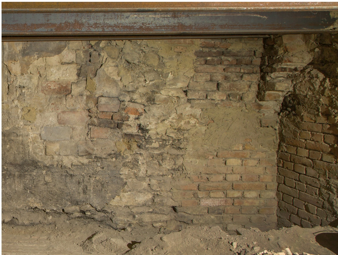
135b_SZ kout se stopami po dymníku. _PH IMG_0573
