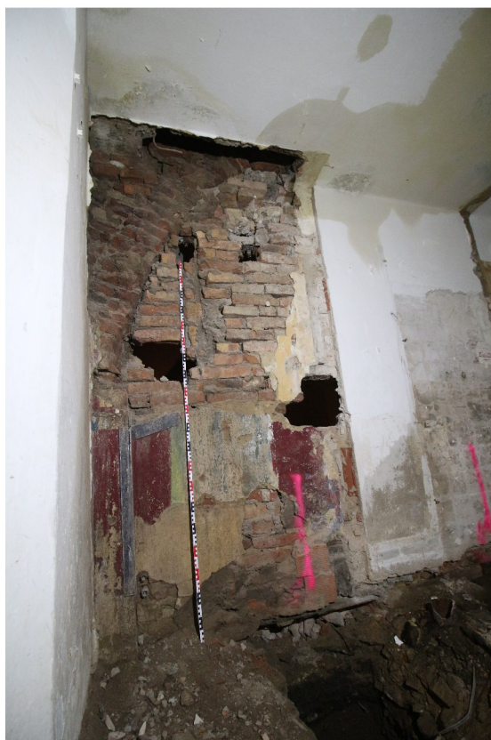
129a_ Místnost 022, pokračování klenebního čela _ KK IMG_1087
