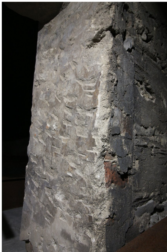
134a_Severní stěna. Vlevo špaleta vstupu s pekovanou omítkou, vpravo otisk stojky trámové zárubně a navazující otisky trámů srubové konstrukce světnice_LB IMG_1173
