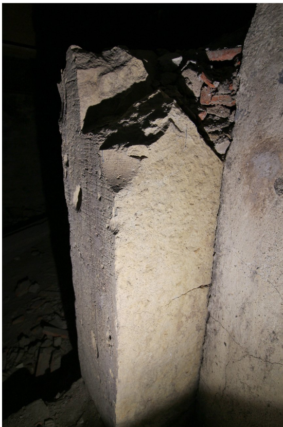
130c_detail stojky portálu s okosením_LB IMG_1106
