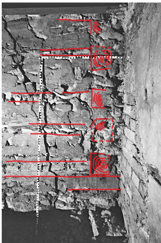
134a_SV kout s otisky čel trámů v nárožní vazbě, zvýrazněno kresbou_LB IMG_1166cb
