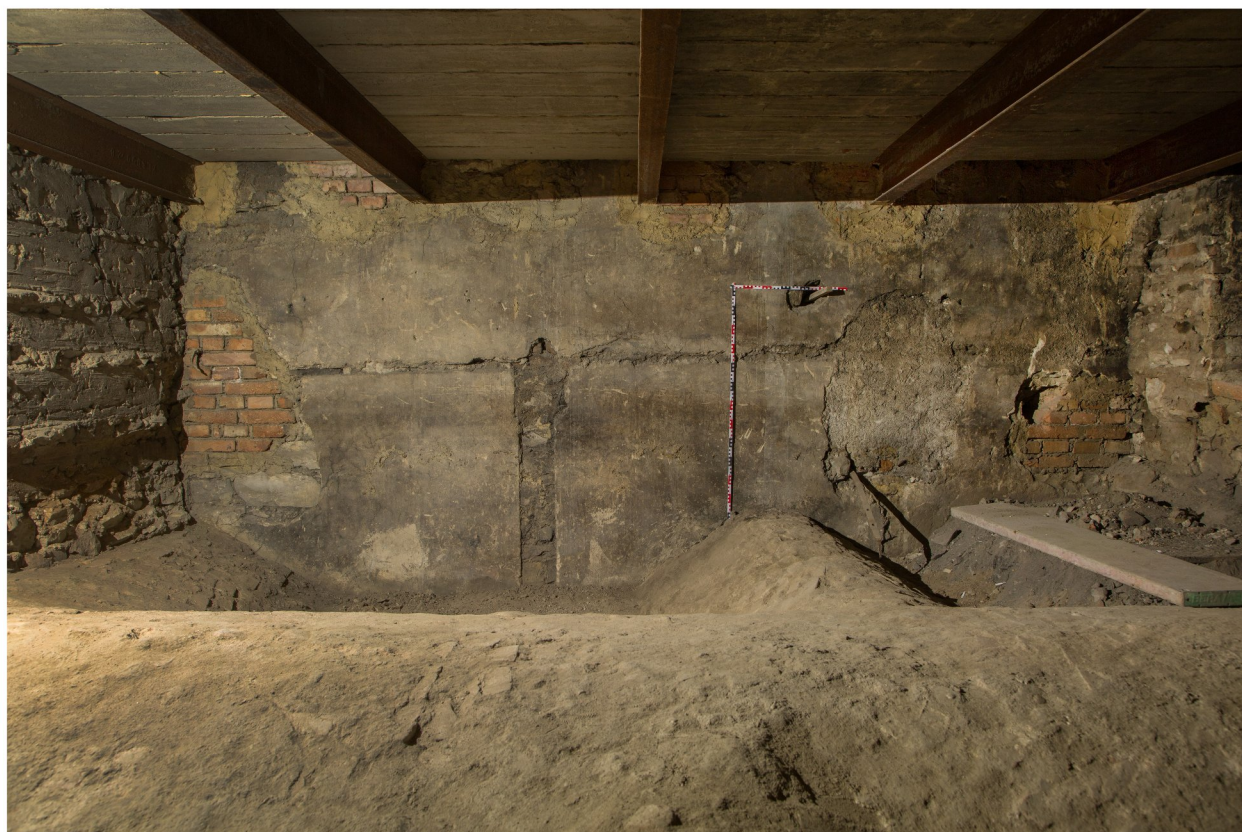
134b_východní stěna s negativem staršího (částečně) dřevěného patra_PH IMG_0558
