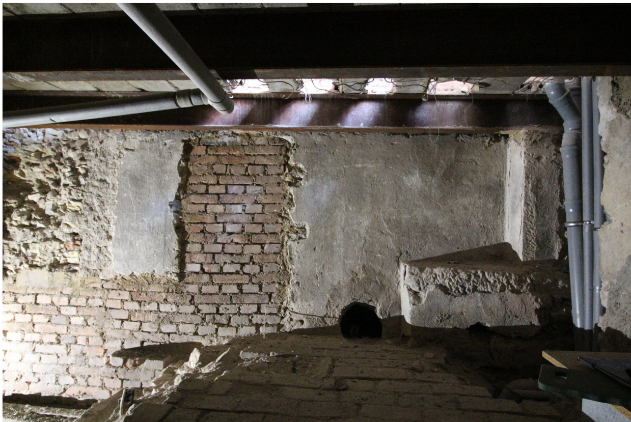
130a_jižní stěna se zazděným segmentově zaklenutým otvorem_KK IMG_2196
