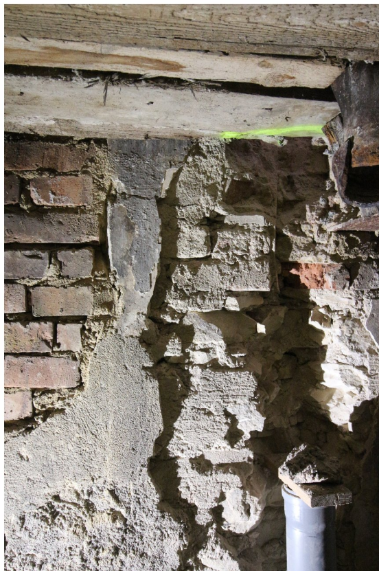
130b_ detail dvou rozdílných fragmentů špalety_KK IMG_2198
