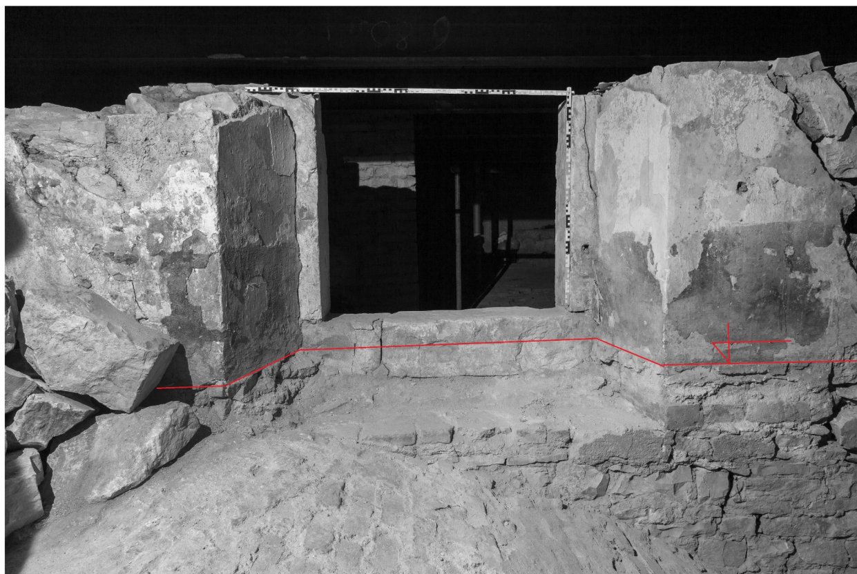
133d_ Jižní stěna s kamenným portálem, otisk podlahy. Pod podlahou rub klenby sálu 125. _PH IMG_0750u
