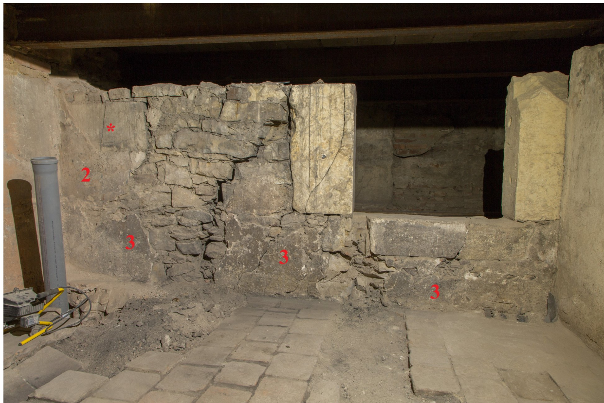
130c_severní stěna s portálem, dvěma fázemi omítek a druhotně použitým kamenickým prvkem_PH IMG_0753p
