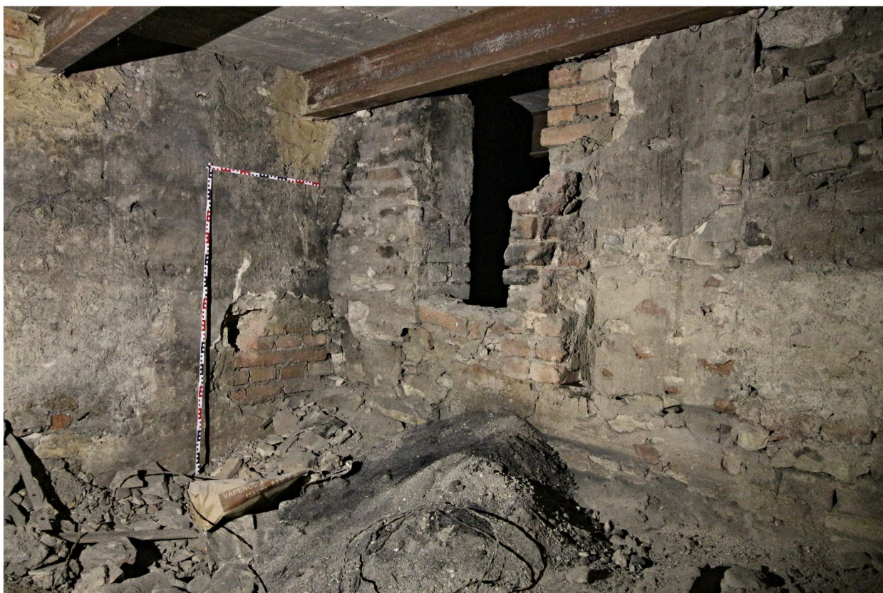
134c_JV kout, pilířek zúžující otvor_LB IMG_1142
