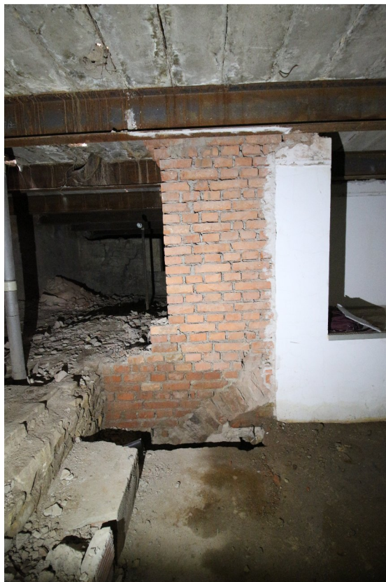
129a_ Novodobá příčka vystavěná na odhalené čelo křížové klenby místnosti 022-023 v přízemí _ KK IMG_1381
