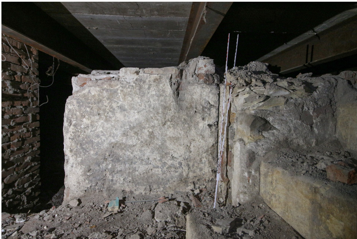
132d_západní stěna se vstupem do 1.30_LB IMG_1114
