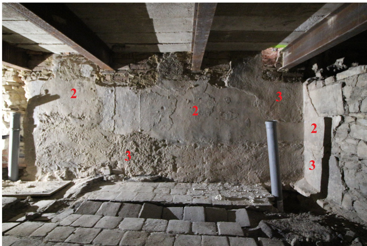
130b_ západní stěna s otiskem sloupku nebo příčky v nátěru omítky_KK IMG_2195p
