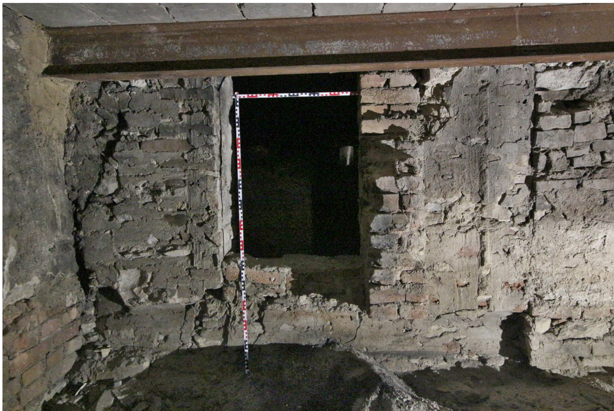
134c_jižní stěna s negativem dřevěné světnice, uprostřed otvor, zúžený cihelným pilířkem, vpravo zazděný otvor, otisky stojek trámových zárubní_LB IMG_1145
