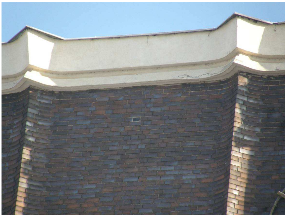
fotografie - detail římsy a zahrocených lizén: zdroj: Jan Mareš (2009)
