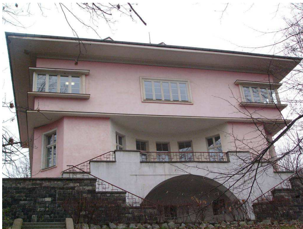
▼ pohled od jihozápadu z Churchillovy ulice
