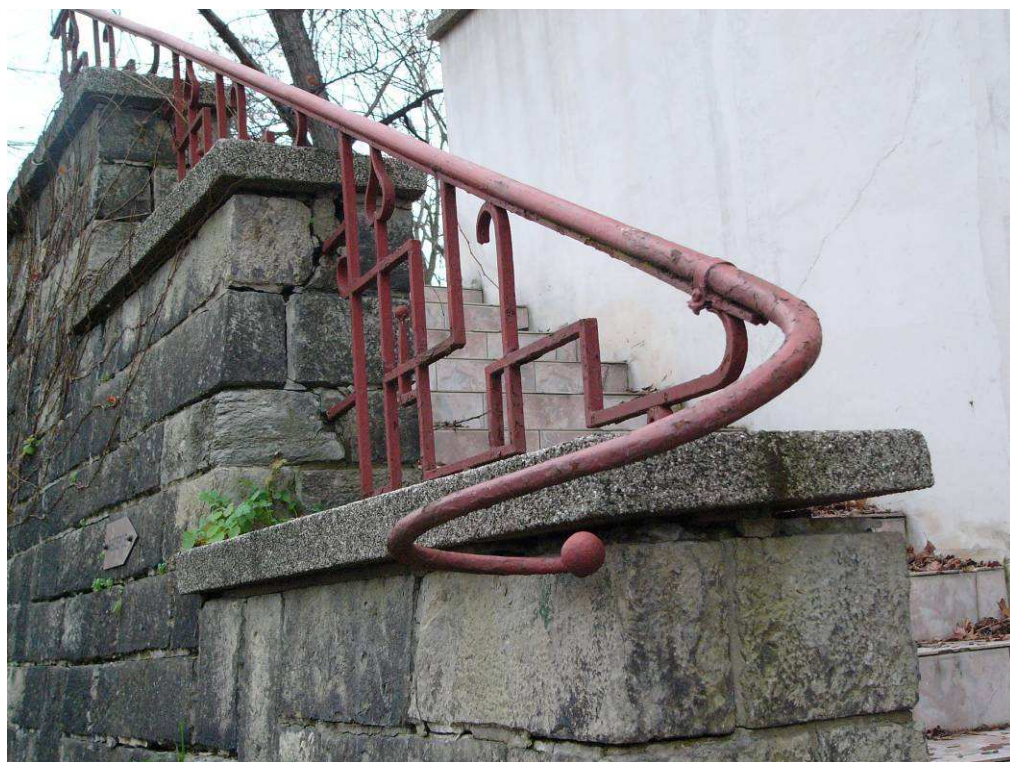
▼ detail zábradlí pod terasou
