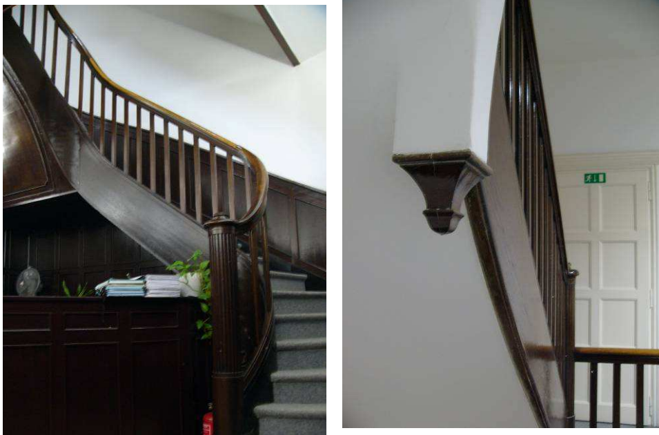
▼ detail, schodiště v hale 1. n. p.
