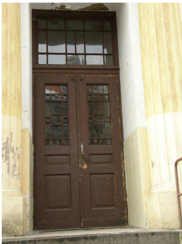
fotografie - detail vstupních dveří a hlavního schodiště: zdroj: Matěj Páral (2009)
