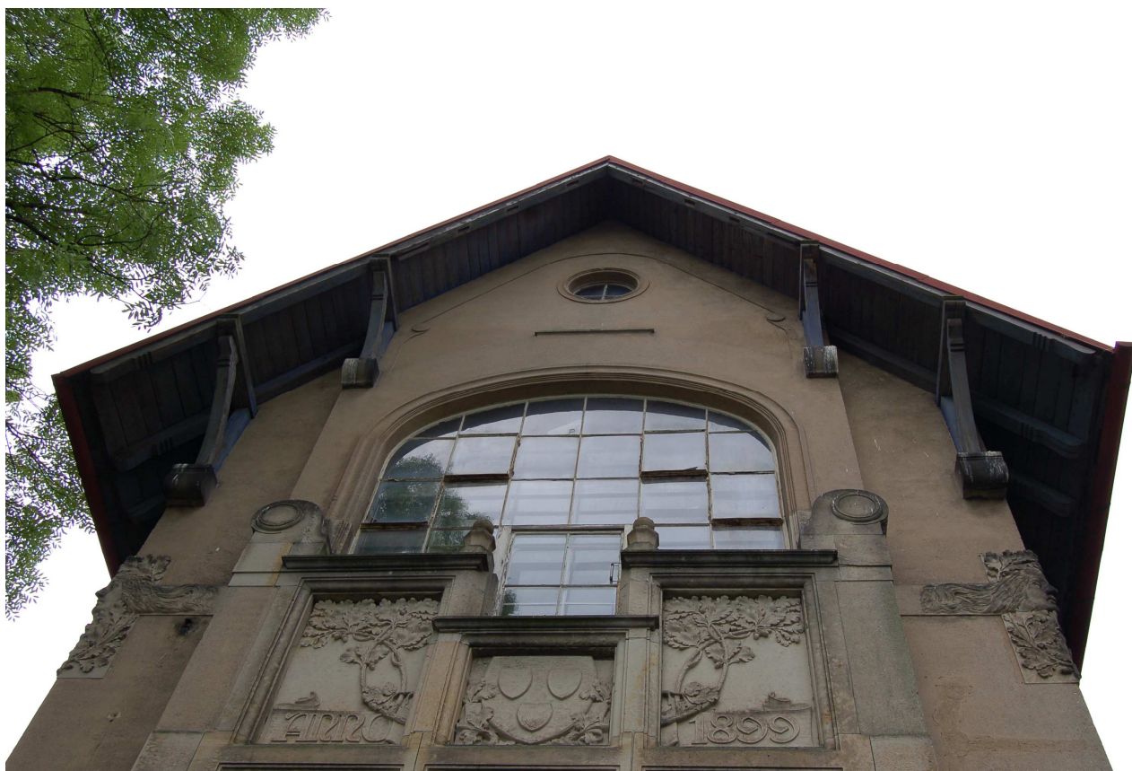
foto 070605ps DSC_0299 – detail rizalitu jižního průčelí
