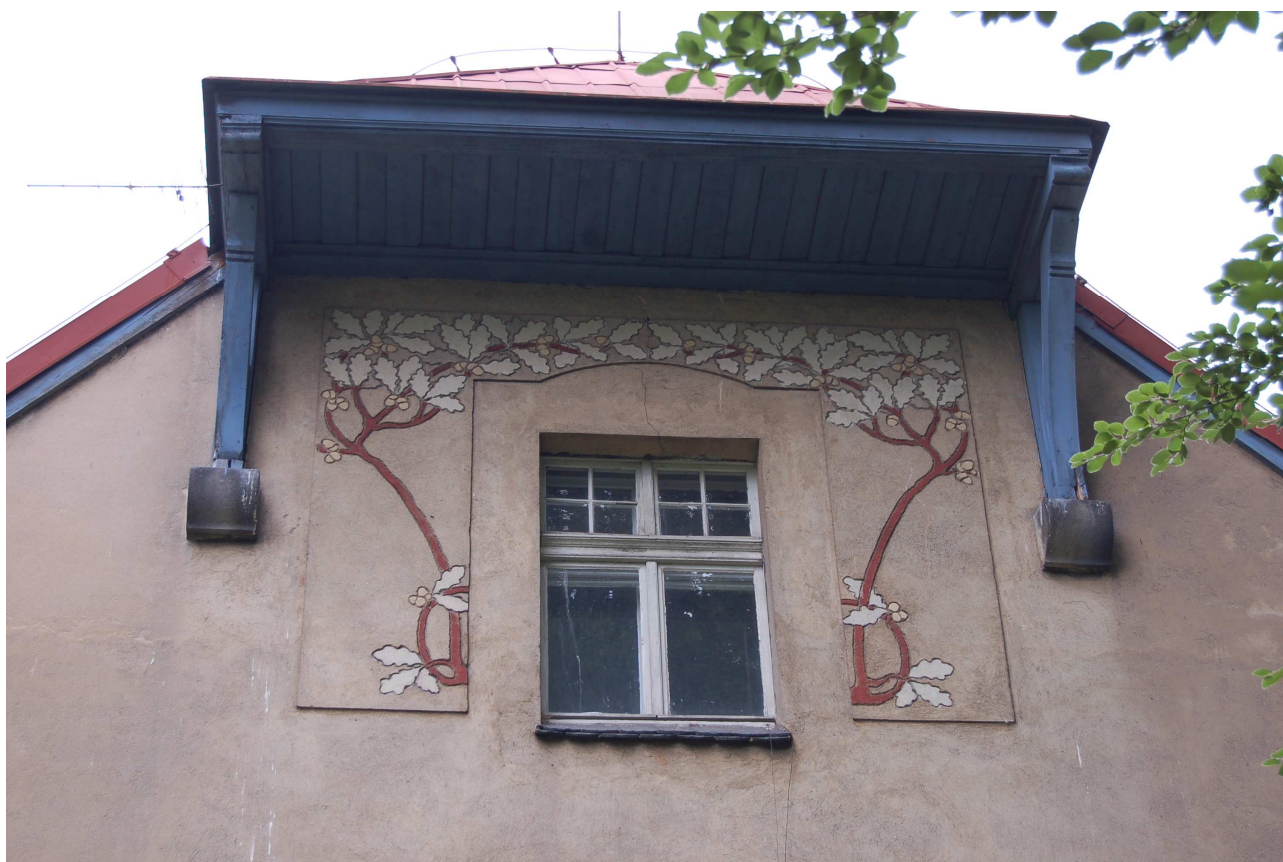
foto 070605ps DSC_0289 – detail štítu západního průčelí
