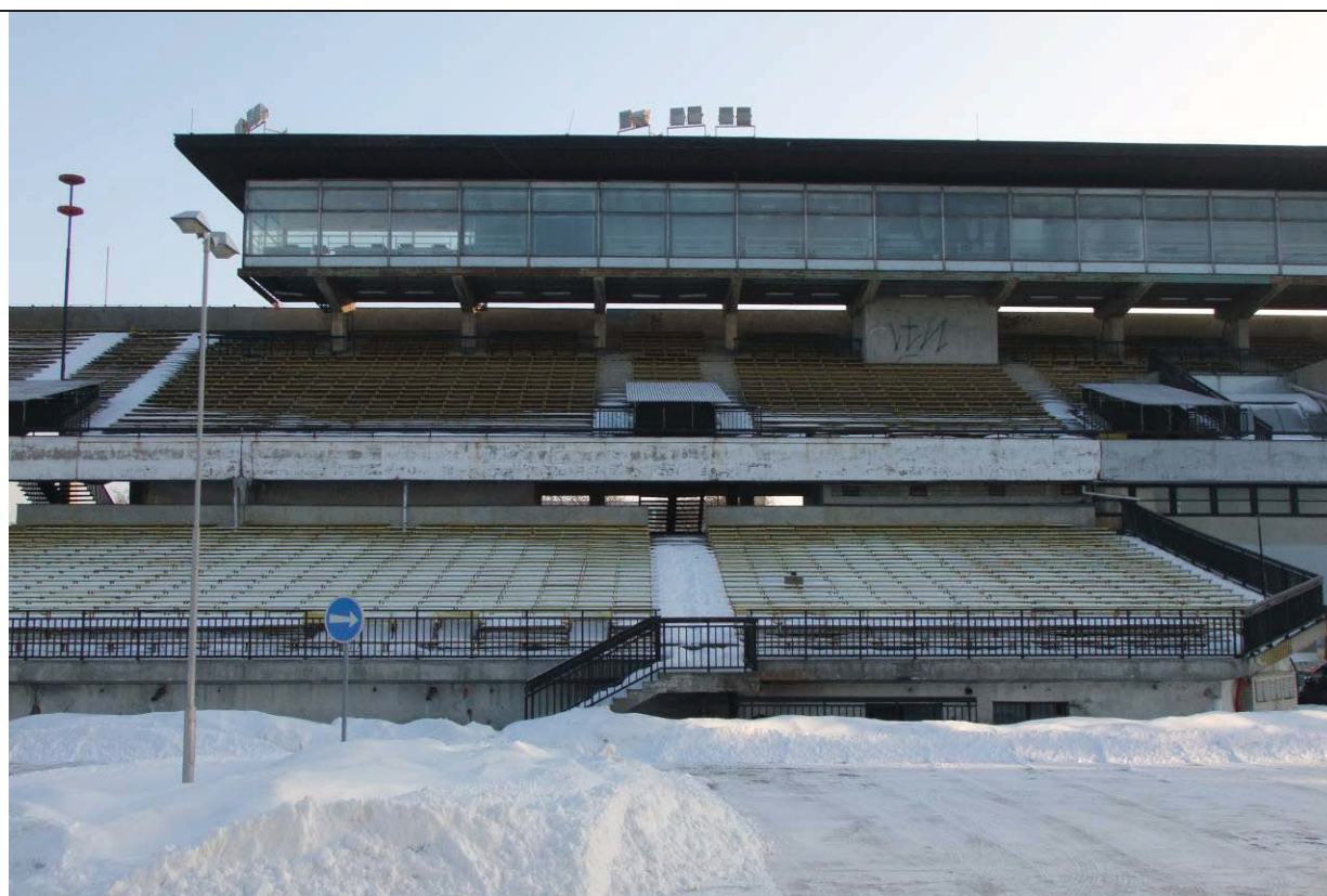
Čelní pohled na východní tribunu, 2010
