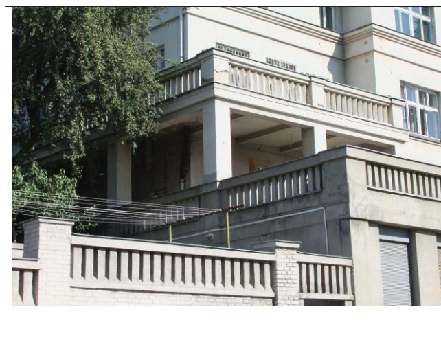
Detail balustrových zábradlí, pohled z ulice Na Stráži.
