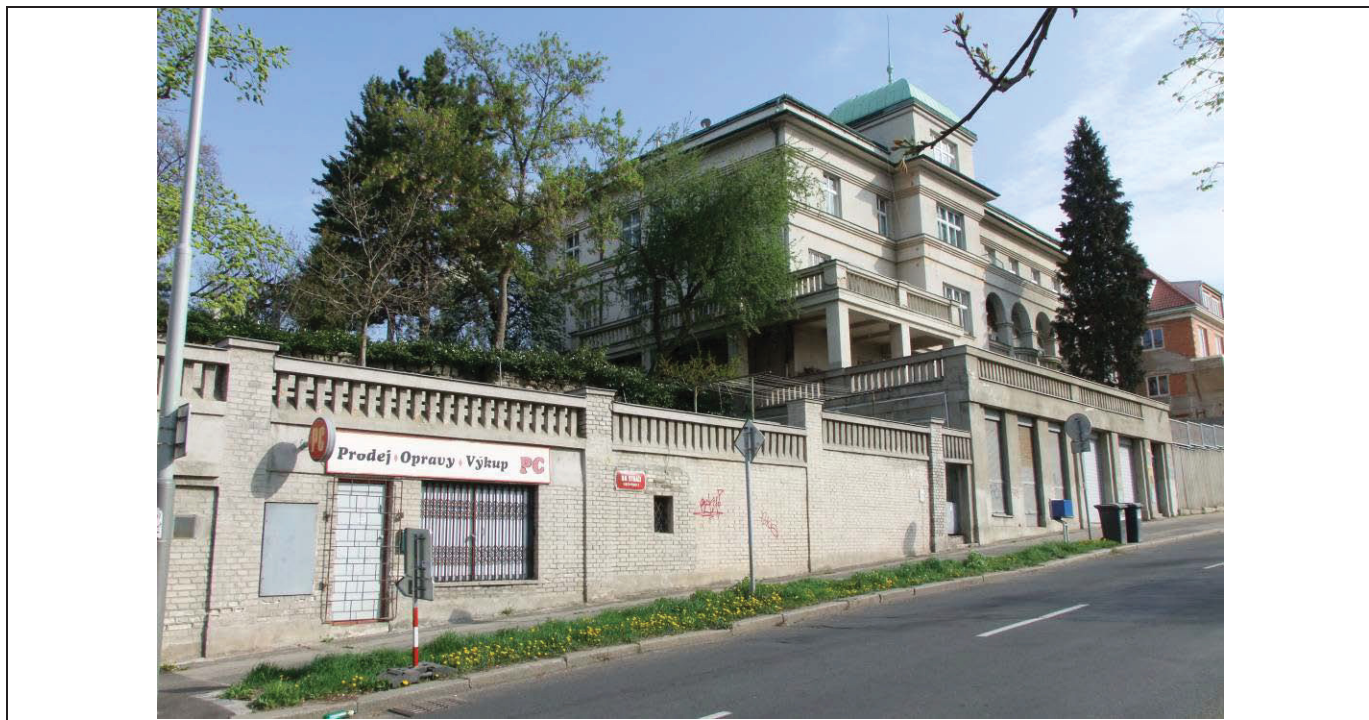
Pohled na jižní a západní fasádu, pohled nahoru ulicí Na Stráži.
