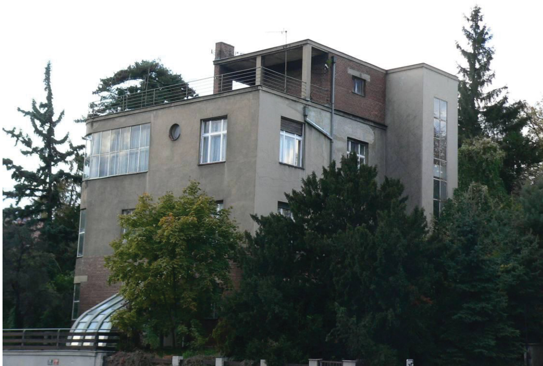
Celkový pohled na jižní a východní fasádu.
