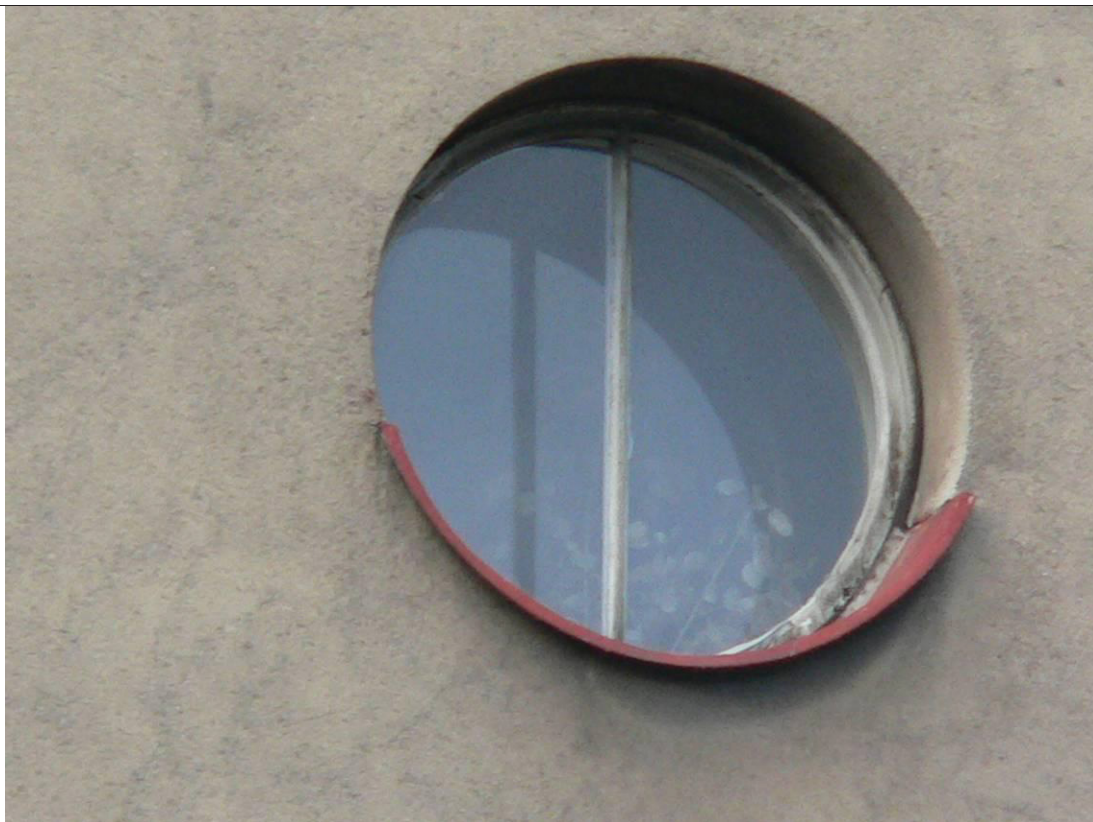
Detail kruhového okna na jižní fasádě.
