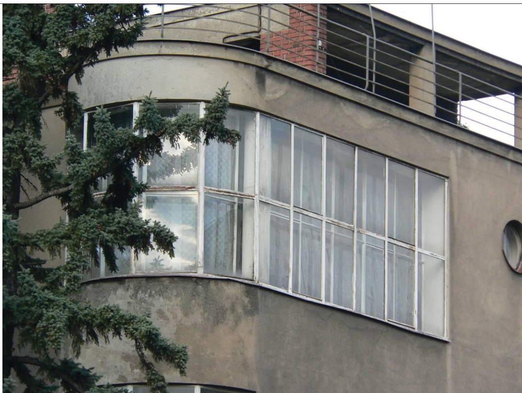
Detail zimní zahrady (verandy) v 1. patře objektu při jižní fasádě.
