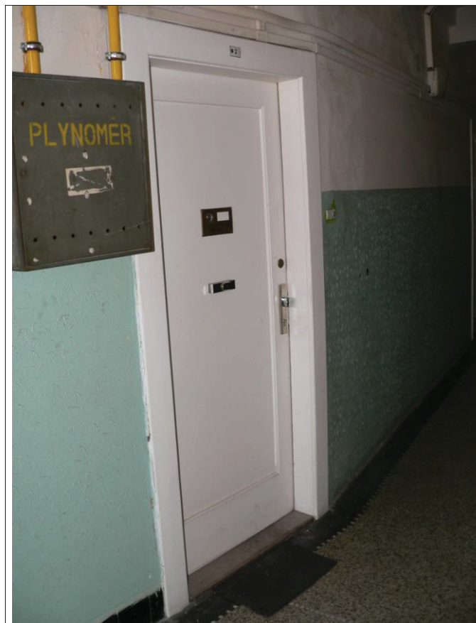
Detail vstupních dveří do bytu.
