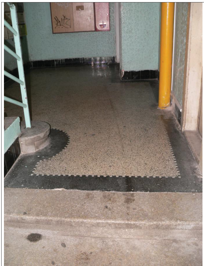
Detail vstupních prostor domu s litým terazzem.
