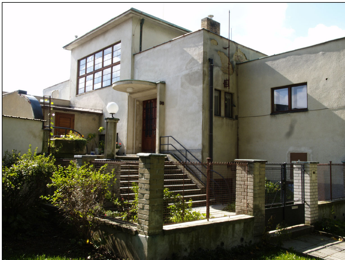
Hlavní vstup, foto 2007, archiv NPÚ Č. Budějovice.
