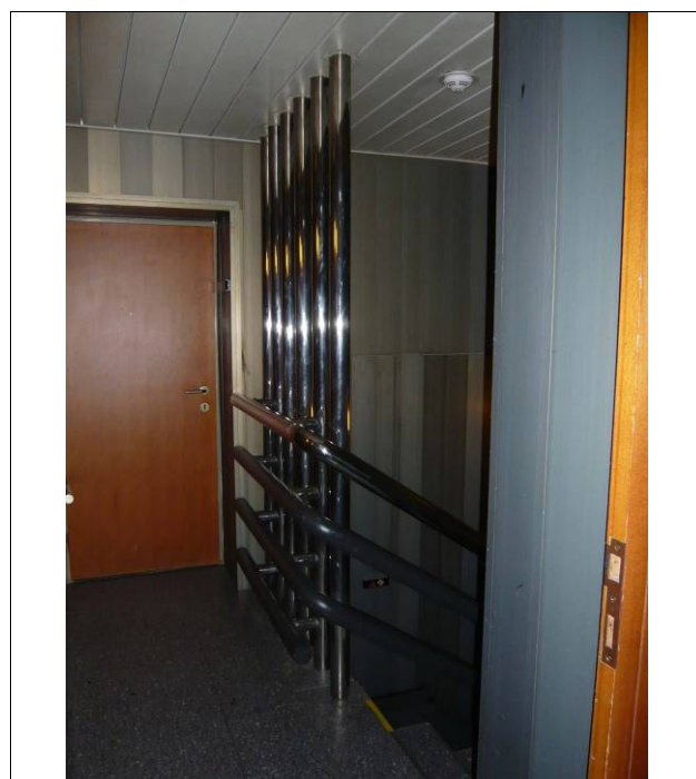
Podesta provozního schodiště, foto 2012.
