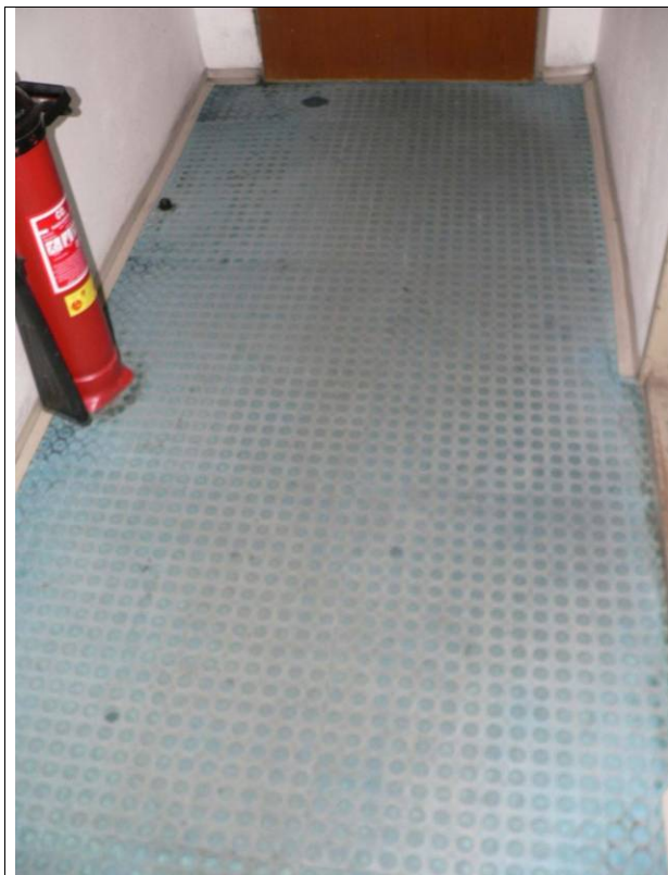
Podlaha chodby v technickém provozu, foto 2012.
