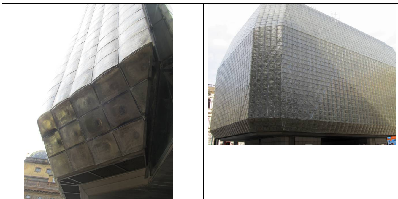
Pohled na fasádu, detail skleněných tvárnic a celek, foto z náměstí, 2012
