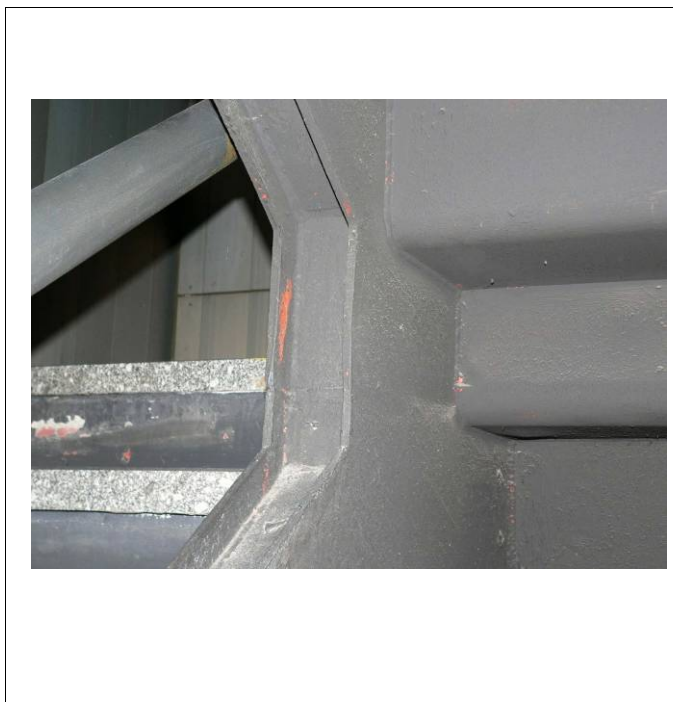
Detail napojení schodnic, foto 2012.
