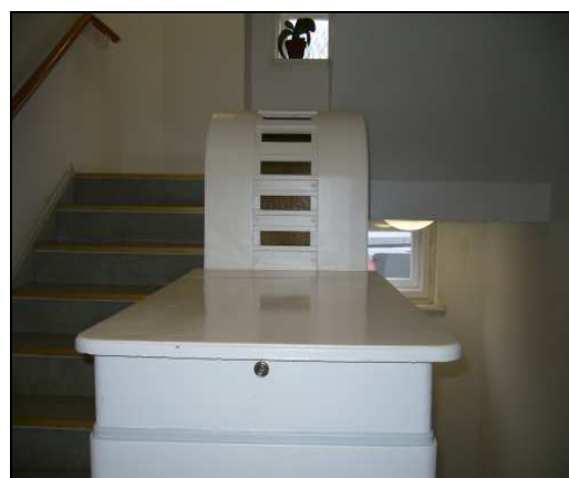
detail schodiště do patra
