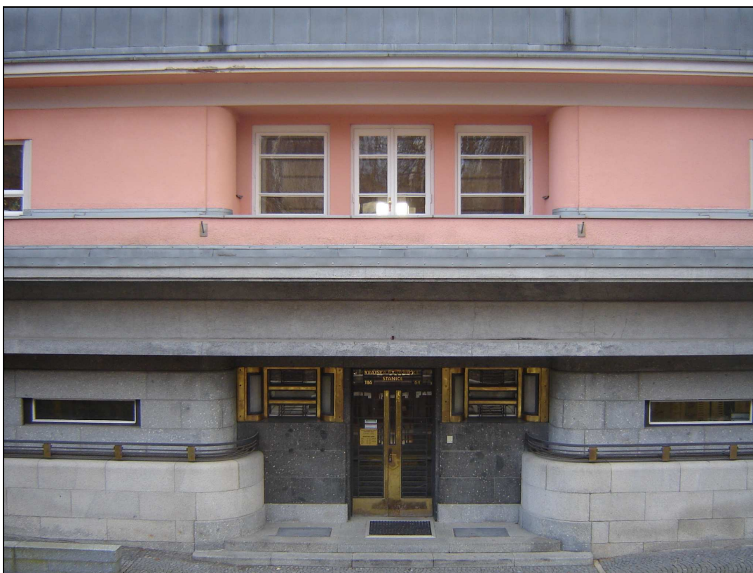
pohled na průčelí domu se vchodem
