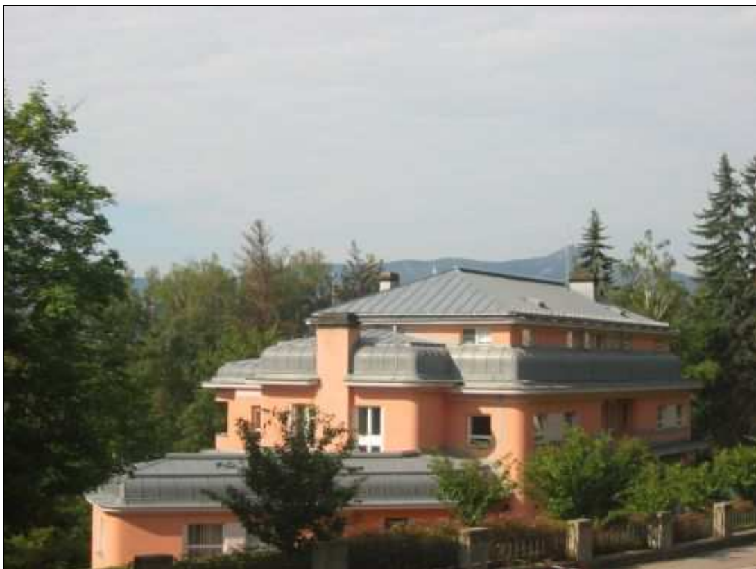
pohled od severovýchodu,
