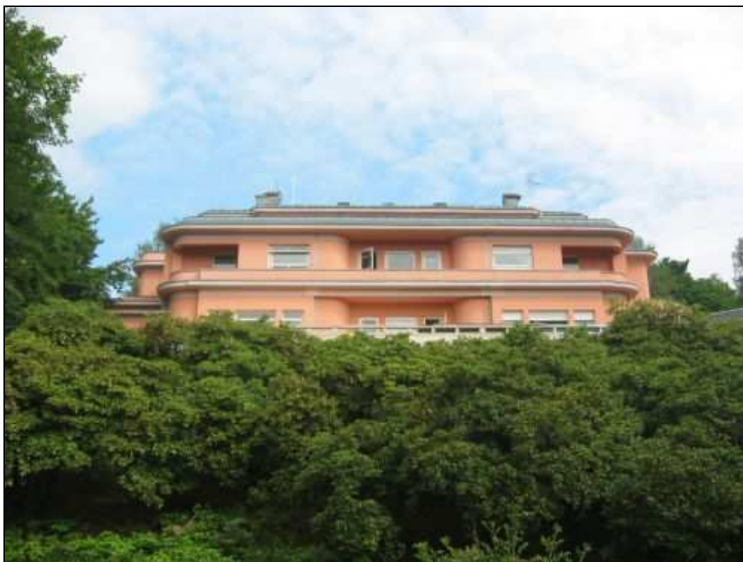
pohled od jihu
