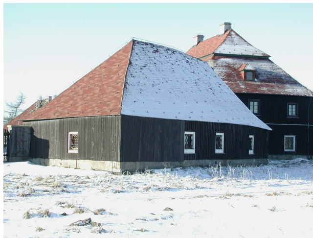
pohled od severovýchodu (12/2004)
