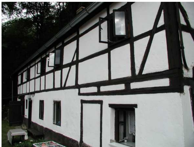
jihozápadní průčelí - pohled od jihu (8/2004)
