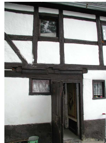
jihozápadní průčelí - část se vstupem do domu (8/2004)
