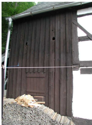
jihozápadní průčelí - kůlna na levé straně domu (8/2004)
