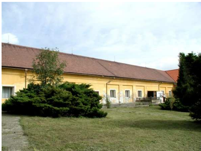
jižní průčelí - pohled od jihozápadu (9/2002)
