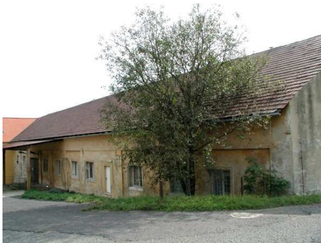
severní průčelí - pohled od severozápadu (9/2002)
