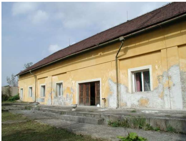
jižní průčelí - západní a střední část, pohled od jihovýchodu (9/2002)
