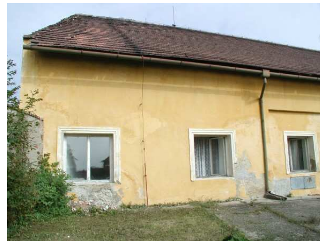
jižní průčelí - západní část (9/2002)
