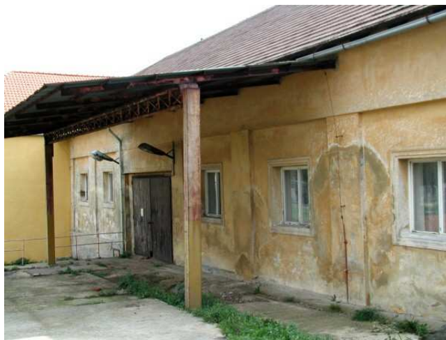
severní průčelí - východní část, pohled od severozápadu (9/2002)
