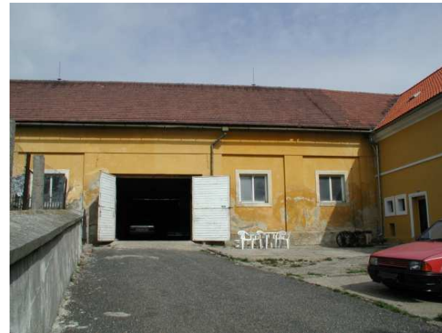
jižní průčelí - osy první, druhá třetí a čtvrtá od východu (vpravo část hospodářské budovy II.) (9/2002)
