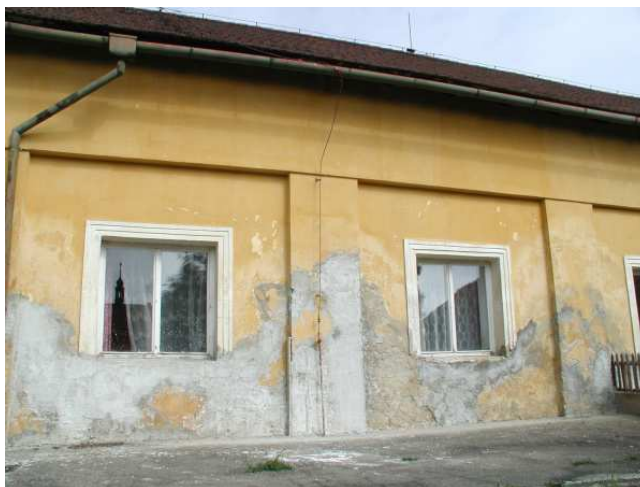
jižní průčelí - okna v osách šesté a sedmé od západu (9/2002)
