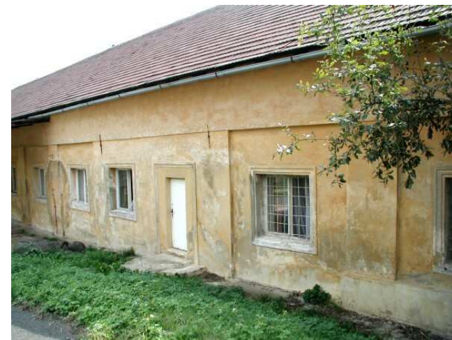
severní průčelí - střední část, pohled od severozápadu (9/2002)
