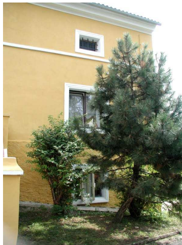
západní průčelí - jižní krajní osa, pohled od severozápadu (9/2002)
