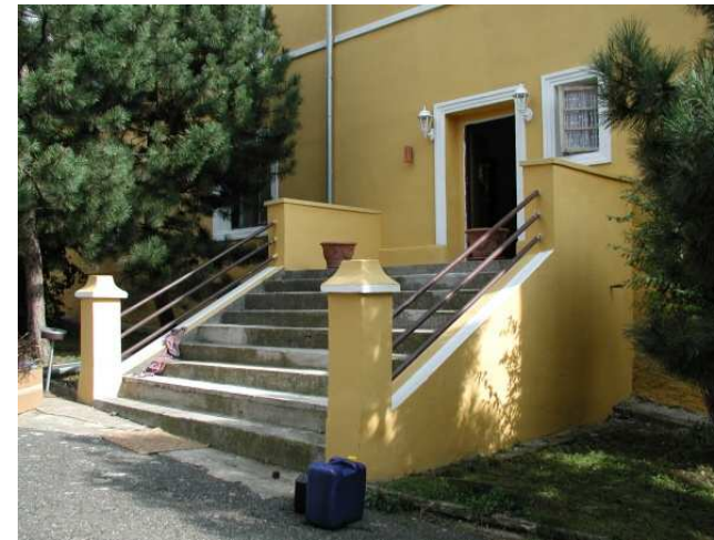
schodiště před západním průčelím - pohled od jihozápadu (9/2002)
