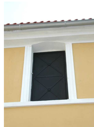
západní průčelí - polopatro, podávací otvor v ose první od severu (9/2002)
