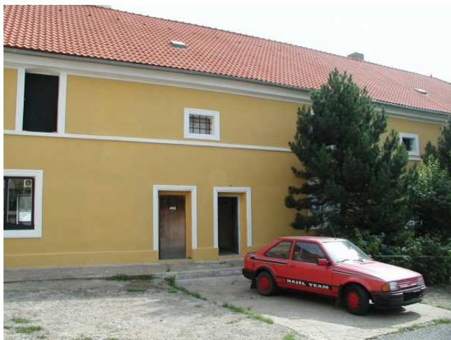
západní průčelí - střední část, pohled od severozápadu (9/2002)
