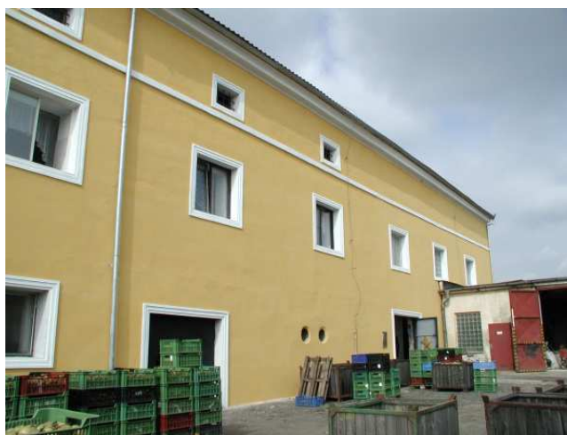
východní průčelí - střední a severní část, pohled od jihovýchodu (9/2002)
