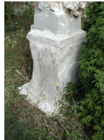
sokl sochy - stav v září 2002
