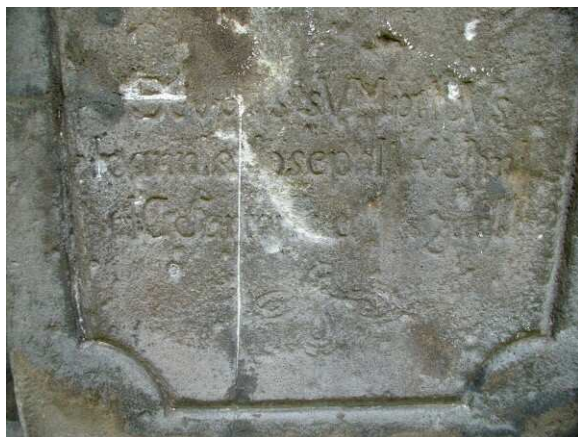
sokl - zadní stěna, detail nápisu v dolní části - pohled od severu (8/2004)
