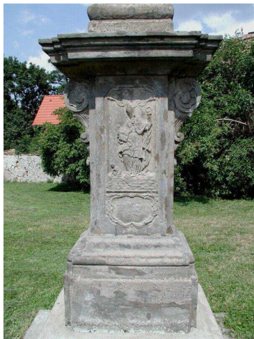
sokl - přední strana, pohled od jihu (8/2004)
