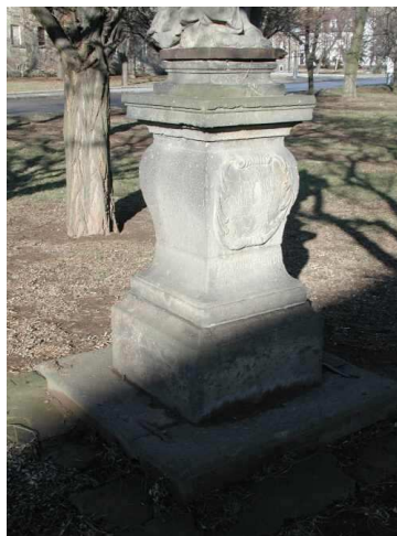
sokl - přední a levá boční strana, pohled od jihu (1/2002)
