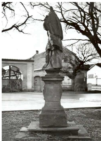
pohled od severovýchodu (1/2002)
