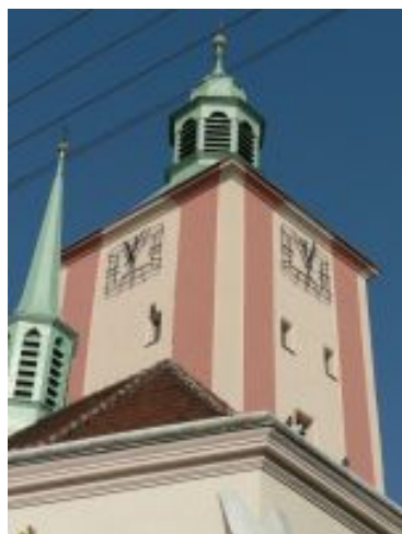
věž - pohled od jihovýchodu (10/2005)
