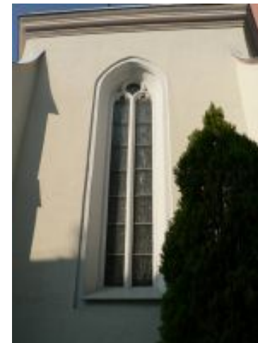
presbytář - závěr, okno ve východní stěně (10/2005)
