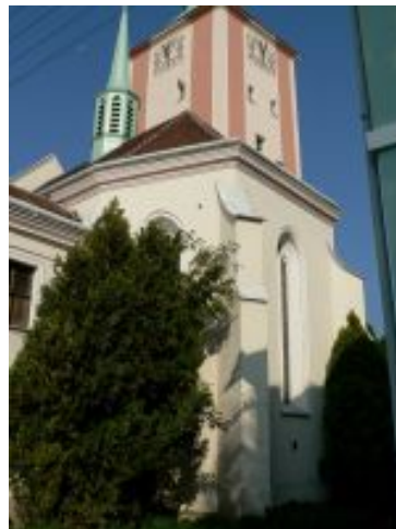
presbytář - pohled od jihovýchodu (10/2005)
