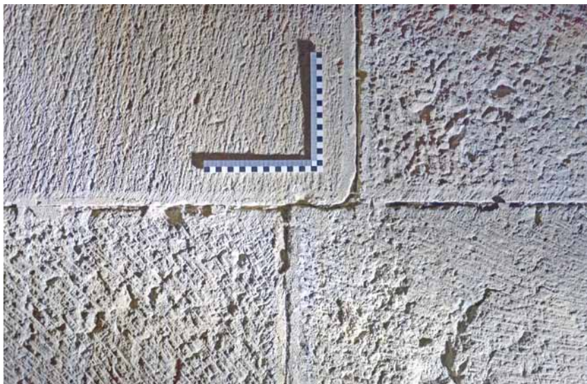
Obr. 9: Fotodokumentace stop historických kamenických nástrojů. Při bočním osvětlení je povrchová textura nejzřetelnější (Teplá – okres Cheb, kostel Zvěstování Páně; foto M. Panáček, 2014).
