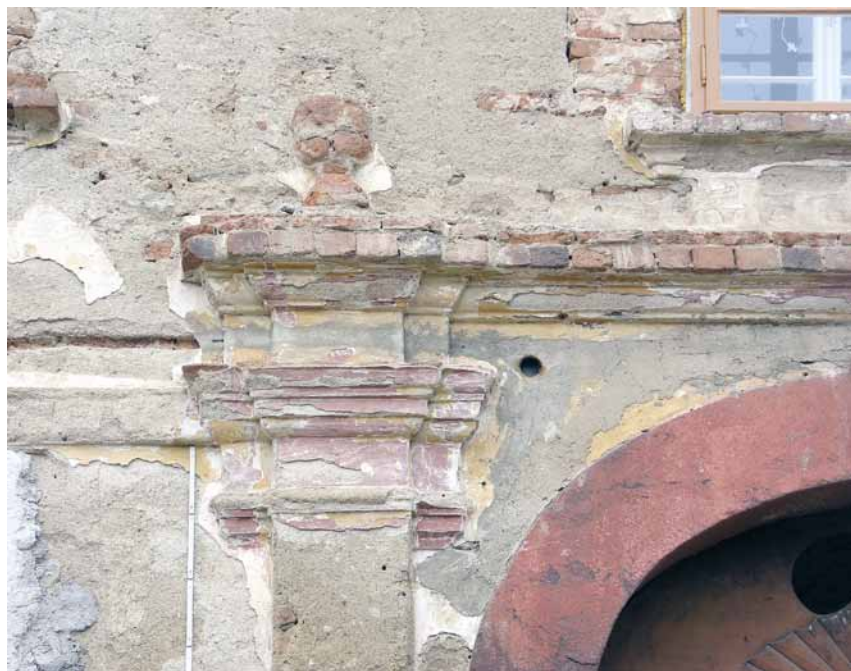
Obr. 19: Měření profilace raně barokní edikuly portálu prokázalo bezradnost či malou zkušenost zedníka při práci s šablonou, která se při modelaci různě nakláněla (Třebešice – okres Benešov, zámek; foto M. Rykl, 2013).
