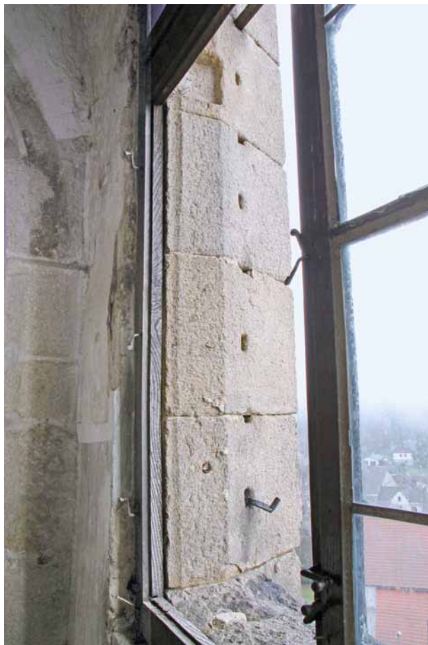
Obr. 13: Architektonické prvky byly často upravovány a nejsou stopy mechanického opotřebení. U okenních ostění docházelo k dodatečnému osazování mříží a vnějších oken (Lipnice nad Sázavou – okres Havlíčkův Brod, hrad; foto F. R. Václavík, 2011).
