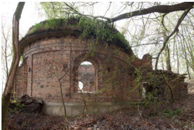
Jezeří, okres Most, Ústecký kraj, 5-299 kaple, zv. Hraběcí, pohled od severozápadu
