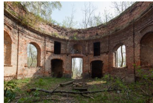
Jezeří, okres Most, Ústecký kraj, 5-299 kaple, zv. Hraběcí, interiér, loď, pohled od západu
