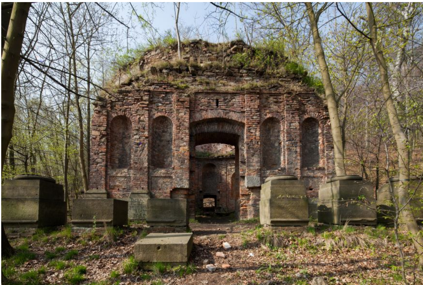
Jezeří, okres Most, Ústecký kraj, 5-299 kaple, zv. Hraběcí exteriér, severovýchodní průčelí, celek, foto od východu
