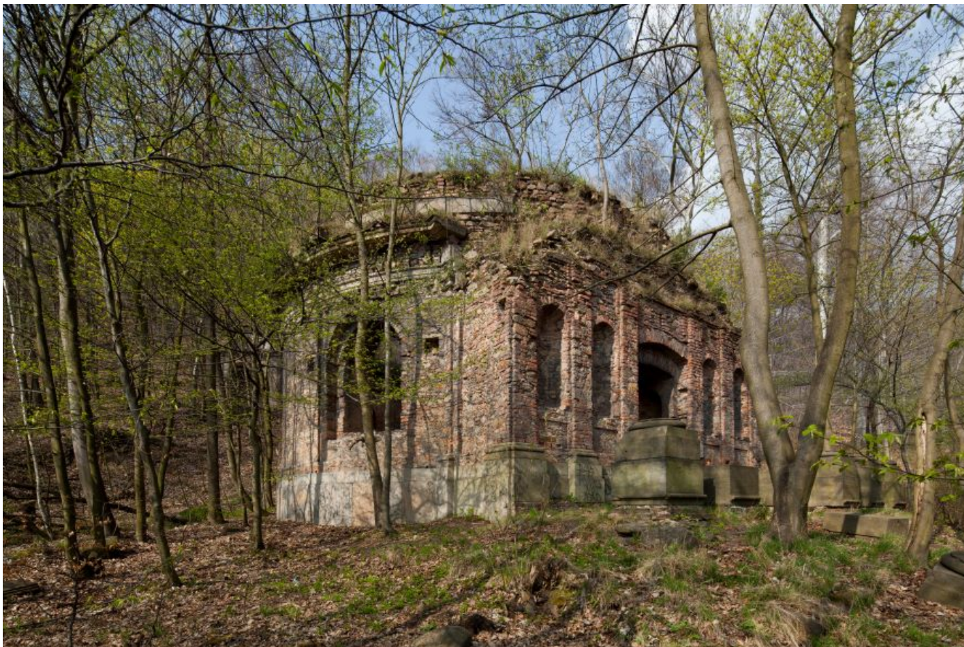
Jezeří, okres Most, Ústecký kraj, 5-299 kaple, zv. Hraběcí, exteriér, jihovýchodní průčelí, pohled od jihovýchodu
