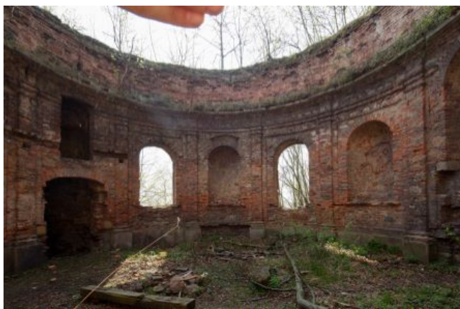
Jezeří, okres Most, Ústecký kraj, 5-299 kaple, zv. Hraběcí, interiér, loď, pohled od severu
