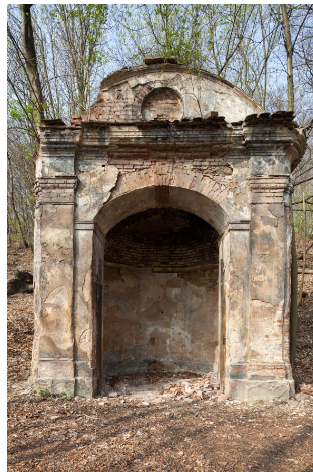
Jezeří, okres Most, Ústecký kraj, 5-301 výklenková kaple, pohled od severovýchodu
