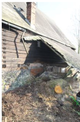
Odbrourané těleso chlebové pece na západní straně objektu. Kamil Podroužek 2014.
