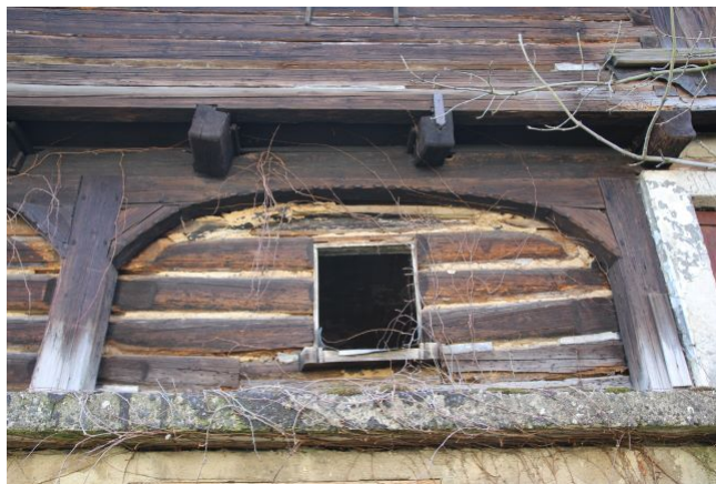
Detail podstavky, roubení a konsol ve východním průčelí. Kamil Podroužek 2014.
