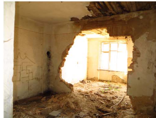
09 Rovné, okres Litoměřice, Ústecký kraj, 5-5708 areál usedlosti č. p. 167 zv. Vladimírov, dům č. p. 167, interiér. západní obytné místnosti.
