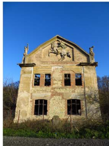
02 Rovné, okres Litoměřice, Ústecký kraj, 5-5708 areál usedlosti č. p. 167 zv. Vladimírov, dům č. p. 167, pohled jižní průčelí.
