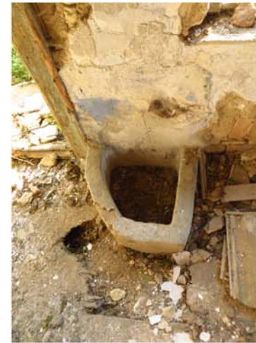
12 Rovné, okres Litoměřice, Ústecký kraj, 5-5708 areál usedlosti č. p. 167 zv. Vladimírov, dům č. p. 167, interiér. východní obytné místnosti. Koryto u východní zdi.
