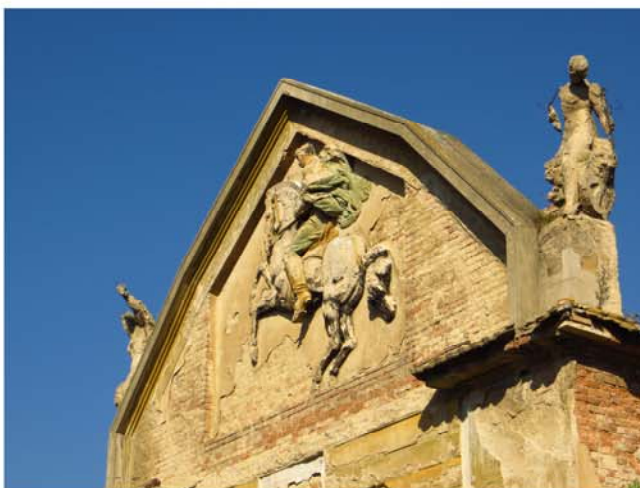
05 Rovné, okres Litoměřice, Ústecký kraj, 5-5708 areál usedlosti č. p. 167 zv. Vladimírov, dům č. p. 167, jižní průčelí, štít.
