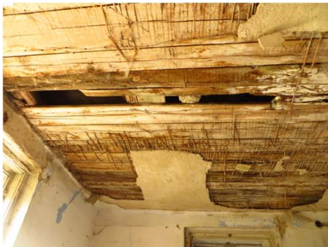
10 Rovné, okres Litoměřice, Ústecký kraj, 5-5708 areál usedlosti č. p. 167 zv. Vladimírov, dům č. p. 167, interiér. Západní obytné místnosti. Strop.
